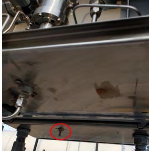
Figura 6. Interruptor de dosificador de mercaptano
