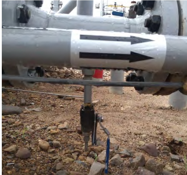
Figura 4. Válvula de recirculación por sobre presión
