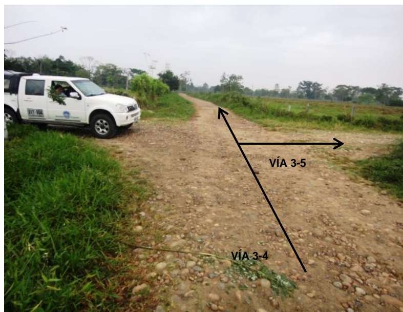
Fotografía 2-24 Buen estado de la vía K0+000, coordenadas 0922856E- 1269929N (magna –este)
