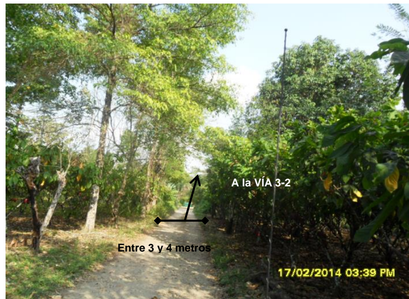
Fotografía 2-19 Regular estado de la vía K1+000, coordenadas 0919892E- 1271223N (magna –este)
