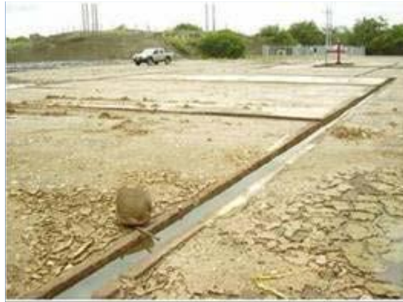
Fotografía 2-73 Cunetas en concreto fundidas in situ para manejo de Aguas aceitosas
