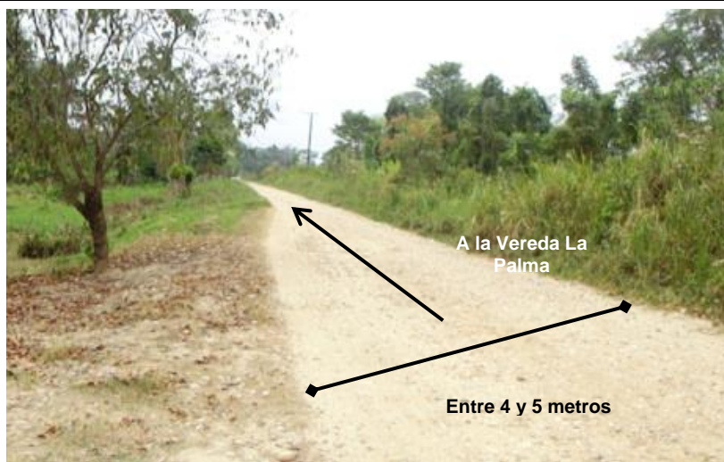
Fotografía 2-16 Buen estado de la vía K2+100, coordenadas 0921355E- 1270825N (magna –este)
