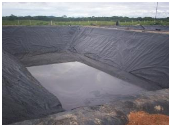
Fotografía 2-76 Tipo de construcción de una piscina de lodos
