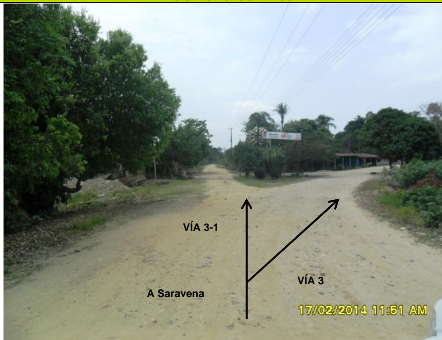
Fotografía 2-15 Buen estado de la vía K12+900, coordenadas 0919440E- 1269273N (magna –este)
