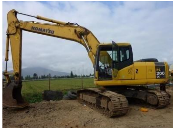
Fotografía 2-52 Corte de material
