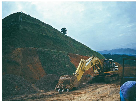
Fotografía 2-62 Revegetación y empradización de taludes
