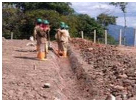
Fotografía 2-68 Construcción de cunetas
