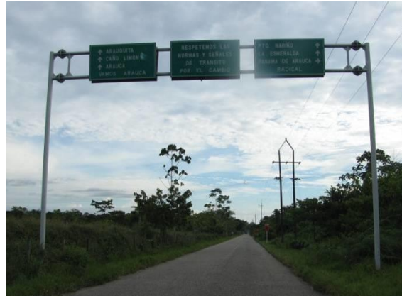
Fotografía 2-1 Ruta 1: Centro poblado de Saravena – Vereda Puerto Nariño (Vía 1) en buen estado
