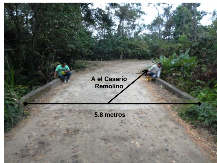
Fotografía 2-21 Buen estado del Pontón K1+400, coordenadas 0922608E- 1269168N (magna –este)
