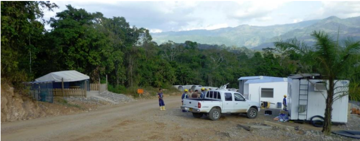
Fotografía 2-51 Campamento temporal de obras civiles
