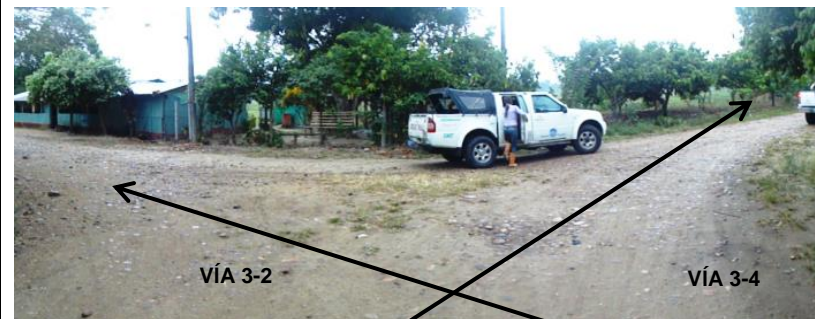
Fotografía 2-23 Buen estado de la vía K3+900, coordenadas 0921810E- 1271316N (magna –este)
