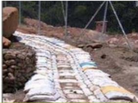
Fotografía 2-69 Cunetas para en sacos rellenos
