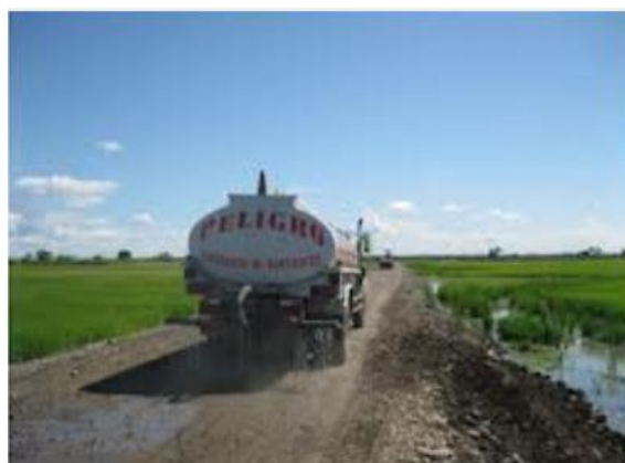
Fotografía 2-85 Humedecimiento de Vías con Carro-tanque
