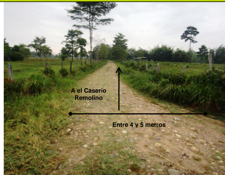
Fotografía 2-25 Buen estado de la vía K0+600, coordenadas 0923019E- 1276321N (magna –este)
