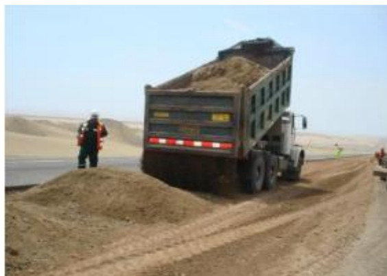
Fotografía 2-54 Colocación de base granular
