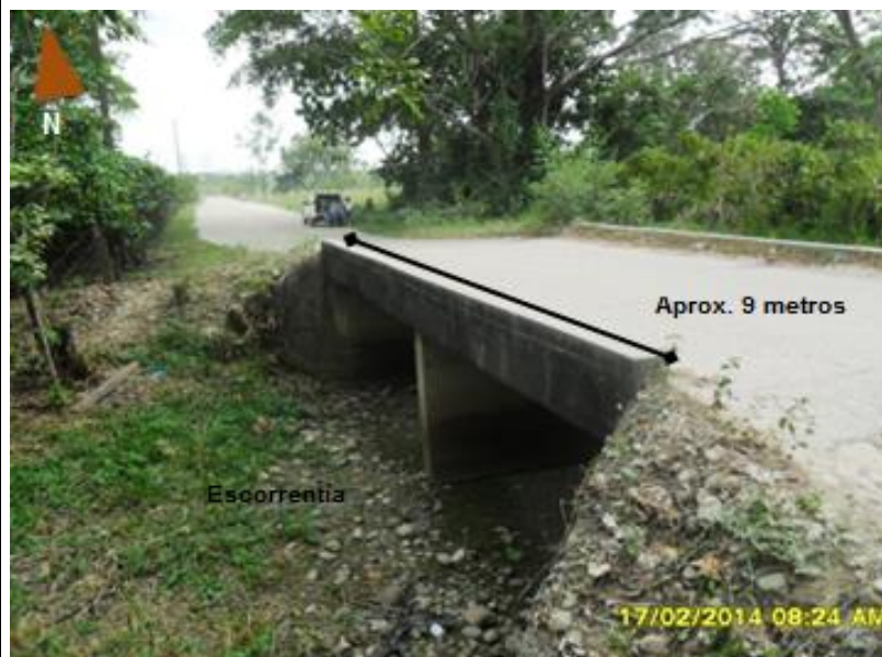
Fotografía 2-10 Box Culvert en buen estado por escoorrentía, coordenadas 0922233E- 1267594N (magna –este)
