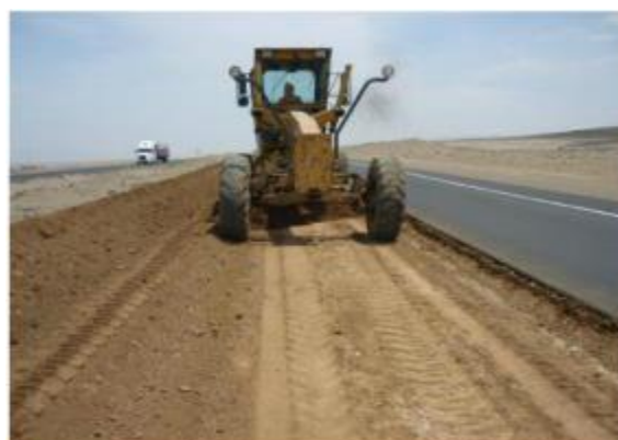
Fotografía 2-56 Mezcla de base granular
