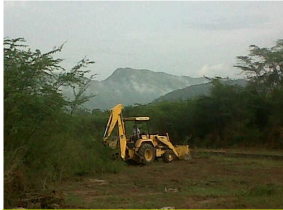
Fotografía 2-60 Desmote y descapote
