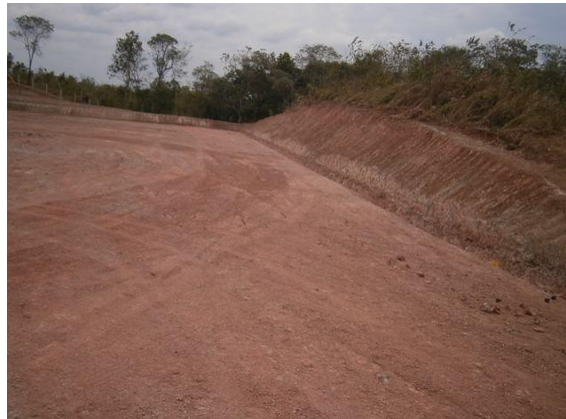
Fotografía 2-61 Nivelación de la subrasante
