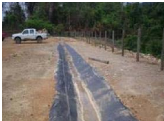
Fotografía 2-70 Cunetas en geomembrana
