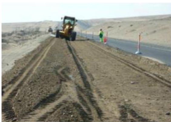
Fotografía 2-55 Extendido del material de base granular
