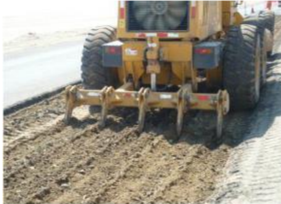
Fotografía 2-57 Escarificación del base granular
