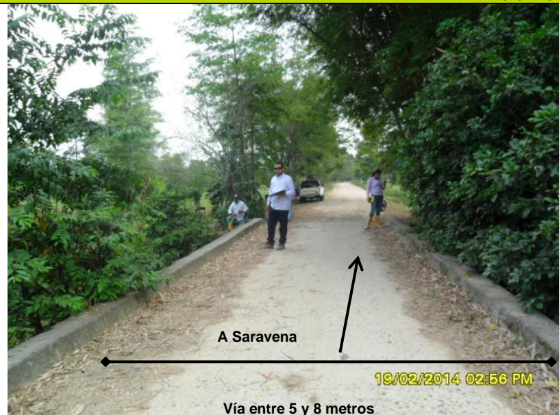
Fotografía 2-13 Buen estado de la vía K11+400, coordenadas 0918893E- 1267944N (magna –este)
