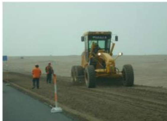
Fotografía 2-58 Conformación de base granular
