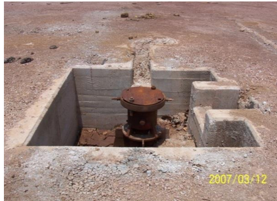
Fotografía 2-63 Cellar o Contrapozo típico
