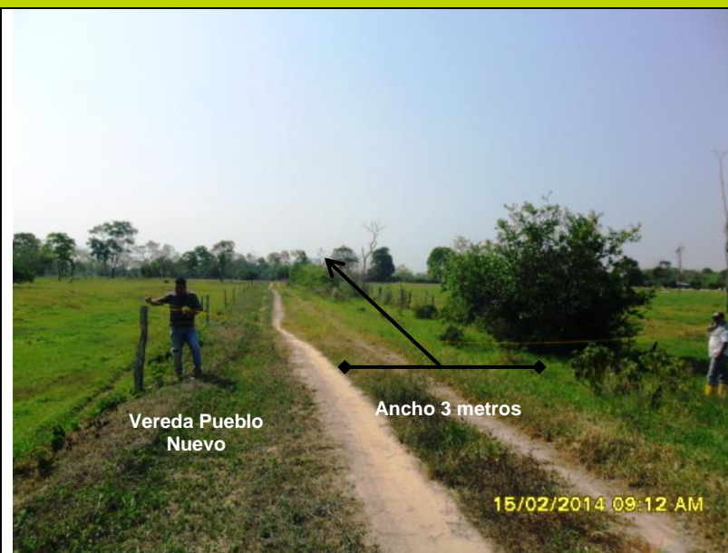
Fotografía 2-40 Regular estado de la vía K3+500, coordenadas 0932764E- 1266302N (magna –este)
