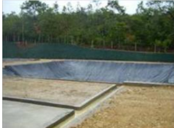
Fotografía 2-77 Piscina impermeabilizada con geomembrana
