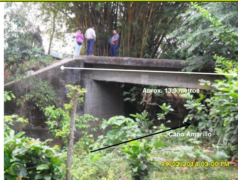
Fotografía 2-14 Buen estado del Pontón K11+400, coordenadas 0918893E- 1267944N (magna –este)
