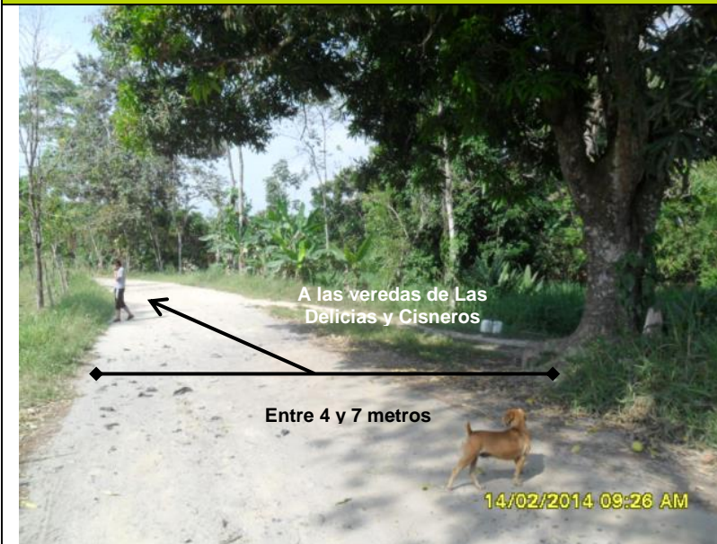
Fotografía 2-28 Buen estado de la vía K2+200, coordenadas 0928785E- 1266690N (magna –este)
