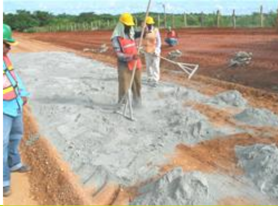
Fotografía 2-66 Estabilización de un suelo con cemento
