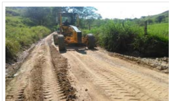
Fotografía 2.12 Cuneteo y nivelación
