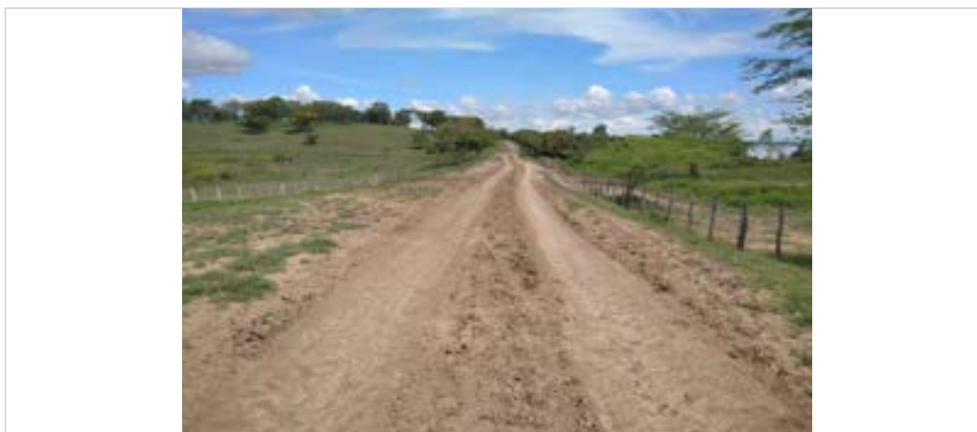
Fotografía 2.1 Estado actual vía
