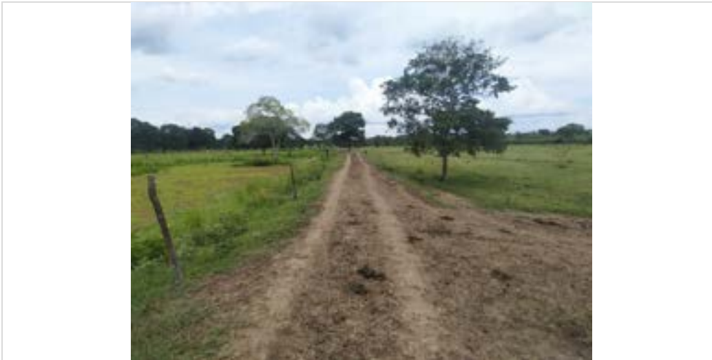
Fotografía 2.7 Estado actual vía Coordenadas: Este 4806233,33; Norte 2657984,94 Fuente: ASI S.A.S., 2020.
