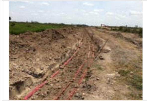
Fotografía 2.26 Instalación de cintas de señalización líneas eléctricas subterráneas
