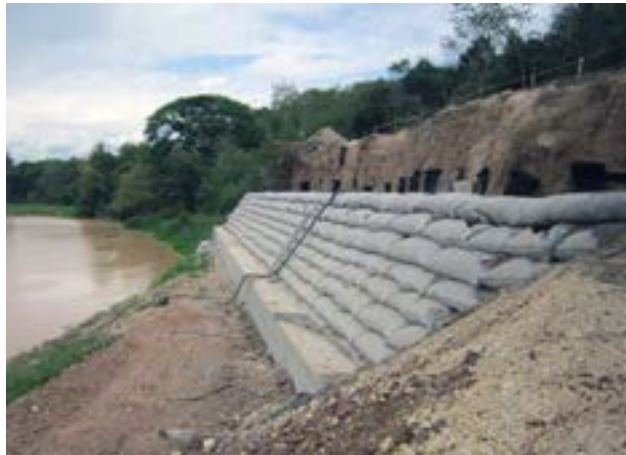
Fotografía 2.17 Muros en gavión. Fuente: PAREX., 2020.
