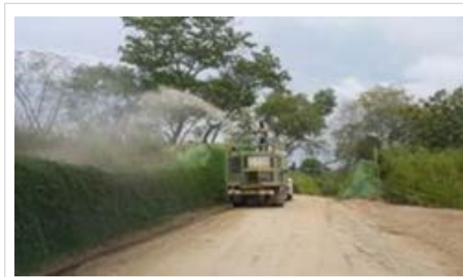
Fotografía 2.15 Riego material vegetal en taludes Fuente: PAREX., 2020.
