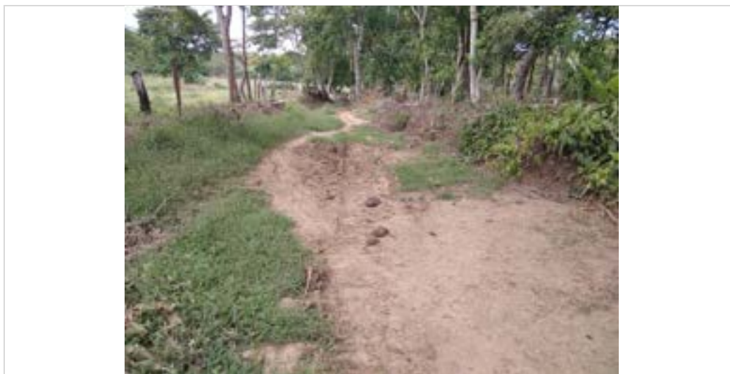
Fotografía 2.4 Estado actual vía Coordenadas: Este 4810581,19; Norte 2648786,63 Fuente: ASI S.A.S., 2020.
