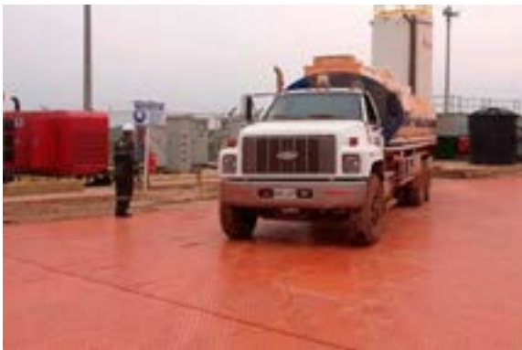
Fotografía 2.10 Superficie modular portátil en polietileno de alta resistencia.
