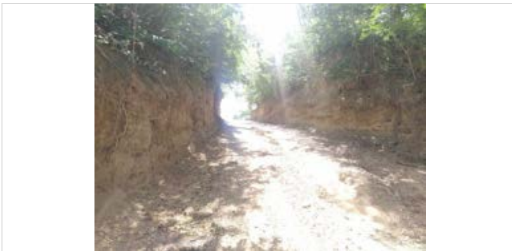
Fotografía 2.6 Estado actual vía
