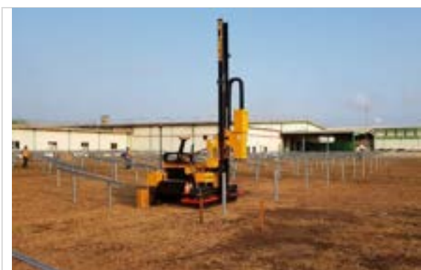
Fotografía 2.29 Máquina para hincado de la estructura de los paneles.
