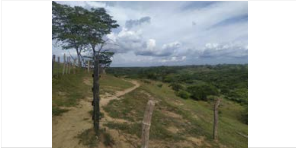
Fotografía 2.5 Estado actual vía Coordenadas: Este 4805298,39; Norte 2652328,78 Fuente: ASI S.A.S., 2020.
