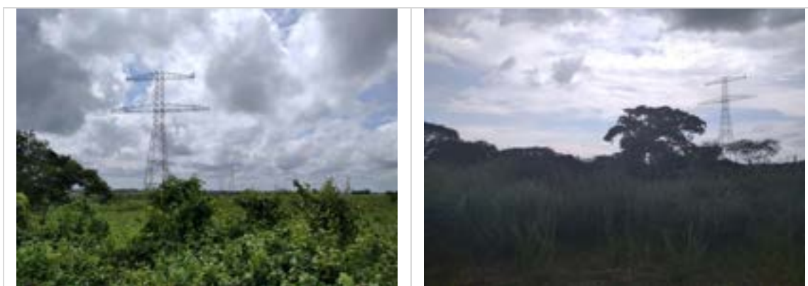
Fotografía 2.15 Torres sin tendido eléctrico
