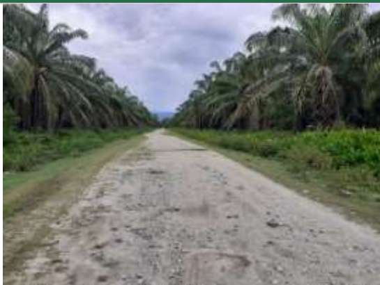
Fotografía 2.63 Estado actual vía Km 2+890 ESTE. 1070562. NORTE. 1342442.
