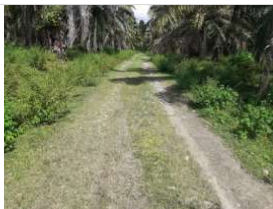
Fotografía 2.110 Estado actual vía 0+010. ESTE. 1071262. NORTE. 1345115.
