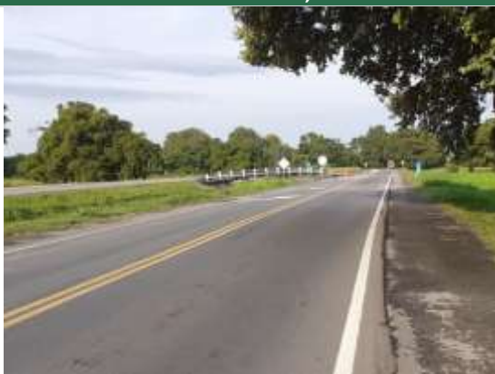
Fotografía 2.5 Estado actual Km 12+000 ESTE:1064786 – NORTE:1342635 Fuente: ASI S.A.S., 2020.
