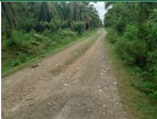
Fotografía 2.67. Estado actual vía Km 3+150 ESTE. 1068423. NORTE. 1340976.
