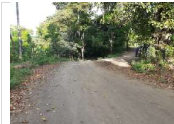
Fotografía 2.181 Acceso a la Vereda Piletas Km 0+000 ESTE. 1079865. NORTE. 1321622 Fuente: ASI S.A.S., 2020.
