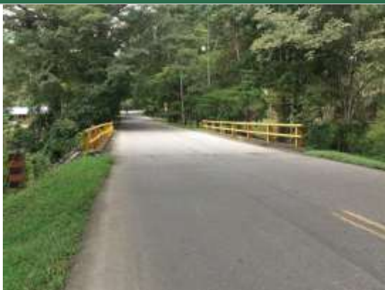
Fotografía 2.11. . Estado actual vía Km 12+700 ESTE. 1081464. NORTE. 1339371. Fuente: ASI S.A.S., 2020.
