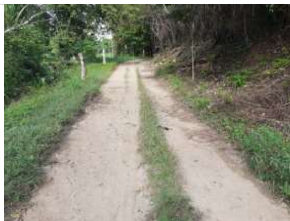
Fotografía 2.184 Estado actual vía km 7+420. ESTE. 1074948. NORTE. 1322441. Fuente: ASI S.A.S., 2020.
