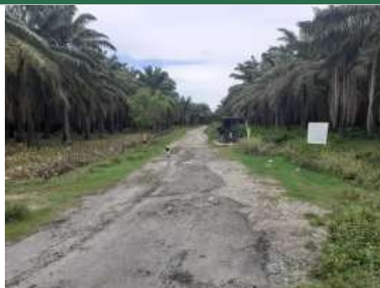
Fotografía 2.82 Fin recorrido – Vía VE-1 km 7+620. ESTE. 1063959. NORTE. 1341883.
