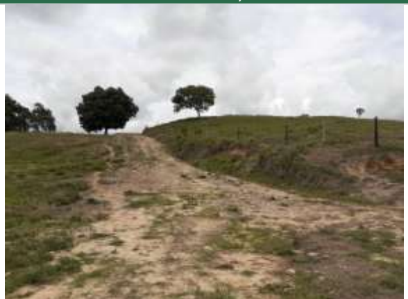
Fotografía 2.150 Material granular vía km 3+400. ESTE. 1072562 NORTE. 1330740 Fuente: ASI S.A.S., 2020.
