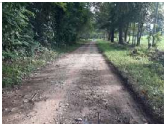
Fotografía 2.182 Estado actual vía km 2+200. ESTE. 1078384. NORTE. 1321457 Fuente: ASI S.A.S., 2020.
