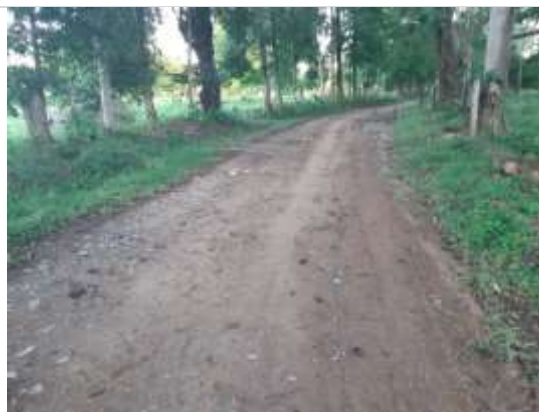
Fotografía 2.38. Estado actual Vía km 2+950. ESTE. 1074977. NORTE. 1346149.
