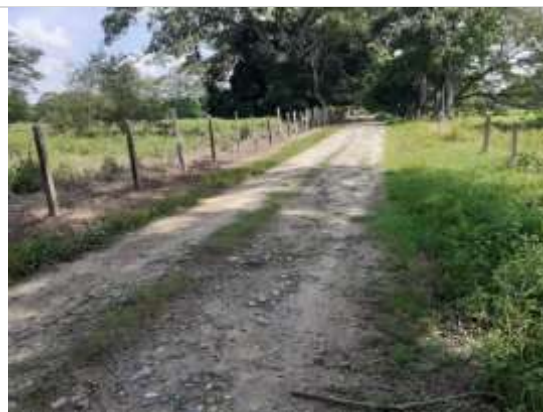
Fotografía 2.194 Estado actual Vía km 2+540. ESTE. 1063836 NORTE. 1343477 Fuente: ASI S.A.S., 2020.
