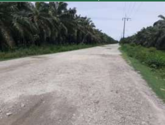
Fotografía 2.19. Estado vía actual Km 4+350 ESTE: 1071320. NORTE: 1342666. Fuente: ASI S.A.S., 2020.
