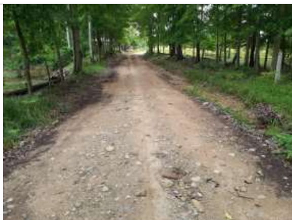
Fotografía 2. 1 Estado actual vía Km 11+800 ESTE. 1070548. NORTE. 1333875. Fuente: ASI S.A.S., 2020.
