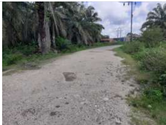
Fotografía 2.76 Estado actual Vía-Planta procesadora de fruto km 2+400. ESTE. 1068808. NORTE. 134405.
