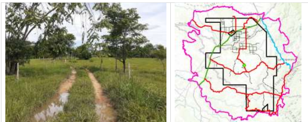
Fotografía 2.251 Estado actual vía Coordenadas: Este 1070779 ; Norte 1335649 Fuente: ASI S.A.S., 2020.
