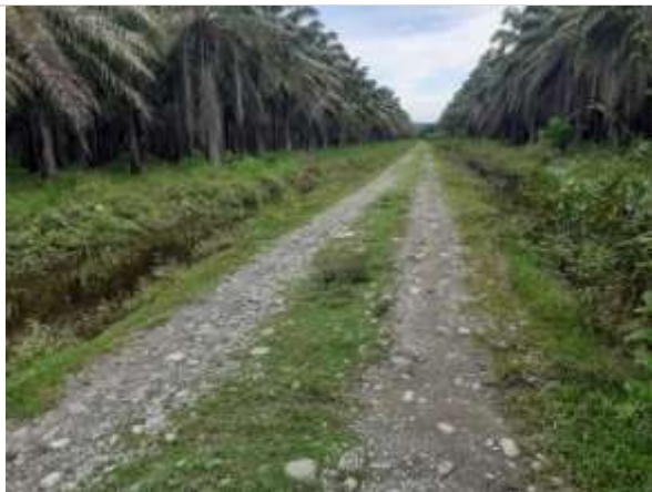
Fotografía 2.69. Estado actual vía Km 0+200 ESTE. 1067296. NORTE. 1340752.
