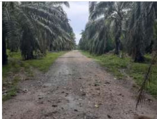
Fotografía 2.230 Estado actual Vía km 1+400. ESTE. 1067210. NORTE. 1347316. Fuente: ASI S.A.S., 2020.
