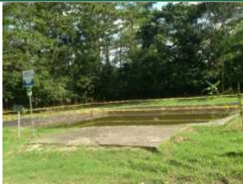
Fotografía 2.243 Piscina de estabilización Fuente: ASI S.A.S., 2019.
