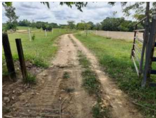
Fotografía 2.146 Estado actual vía km 0+200. ESTE. 1071618 NORTE. 1334183. Fuente: ASI S.A.S., 2020.
