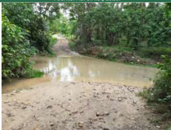
Fotografía 2.119 Ocupación de cauce Km 27+100 ESTE. 1081696. NORTE. 1336254. Fuente: ASI S.A.S., 2020.
