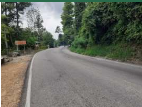
Fotografía 2.13. . Estado actual vía Km 19+400 ESTE. 1084518. NORTE. 1335944. Fuente: ASI S.A.S., 2020.
