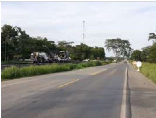
Fotografía 2.7. Trabajo sobre la vía Km 24+600 ESTE: 1058983. NORTE: 1332263 Fuente: ASI S.A.S., 2020.
