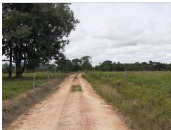
Fotografía 2.144 Estado actual vía km 1+000. ESTE. 1071107. NORTE. 1333090 Fuente: ASI S.A.S., 2020.
