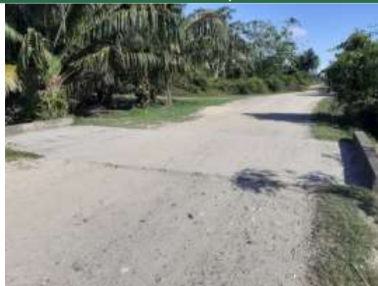
Fotografía 2.200 Fin recorrido km 4+750. ESTE. 1063657. NORTE. 1350026. Fuente: ASI S.A.S., 2020.
