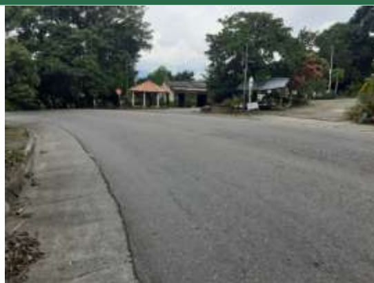
Fotografía 2.14. Acceso a contadero km 20+900. ESTE. 1084834. NORTE. 1334504. Fuente: ASI S.A.S., 2020.
