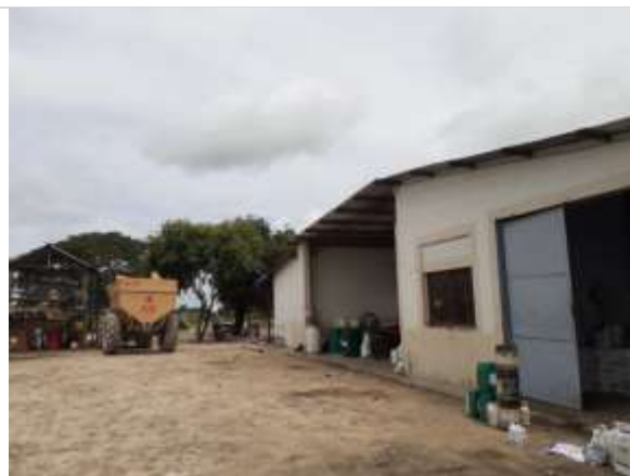
Fotografía 2.140. Instalaciones arrocera Finca el Hato km 0+580. ESTE. 1067838 NORTE. 1332874 Fuente: ASI S.A.S., 2020.
