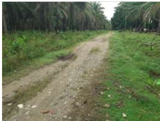
Fotografía 2.66. Estado actual Vía km 2+100. ESTE. 1069458. NORTE. 1341132.
