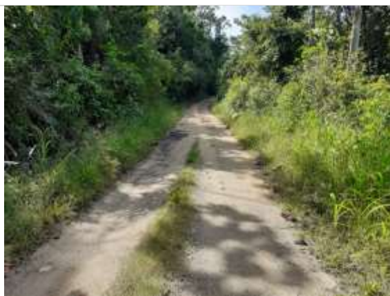
Fotografía 2.159 Estado actual vía Km 9+900 ESTE. 1079432. NORTE. 1329064. Fuente: ASI S.A.S., 2020.
