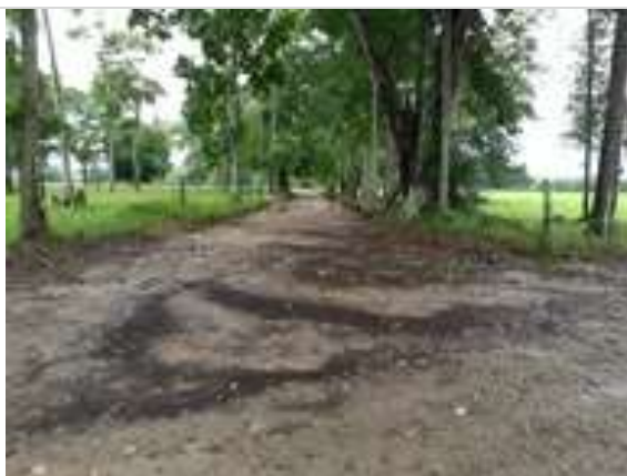
Fotografía 2.121 Acceso a la vía CV-2.1 Km 0+000 ESTE. 11060884. NORTE. 1337499. Fuente: ASI S.A.S., 2020.
