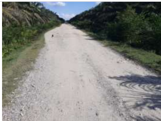
Fotografía 2.198 Estado actual Vía km 1+800. ESTE. 1063663. NORTE. 1347866. Fuente: ASI S.A.S., 2020.
