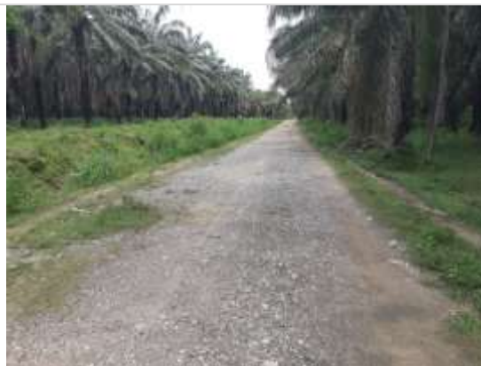
Fotografía 2.80 Estado actual Vía km 0+650. ESTE. 1069290. NORTE. 1343401.
