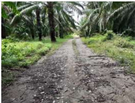
Fotografía 2.206 Estado actual Vía km 2+100. ESTE. 1065835 NORTE. 1347285 Fuente: ASI S.A.S., 2020.
