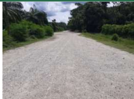
Fotografía 2.77 Estado actual vía Km 4+200 ESTE. 1068252. NORTE. 1345217.
