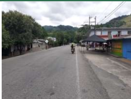
Fotografía 2.12. Municipio La Esperanza km 16+100. ESTE. 1082745 NORTE. 1336635. Fuente: ASI S.A.S., 2020.
