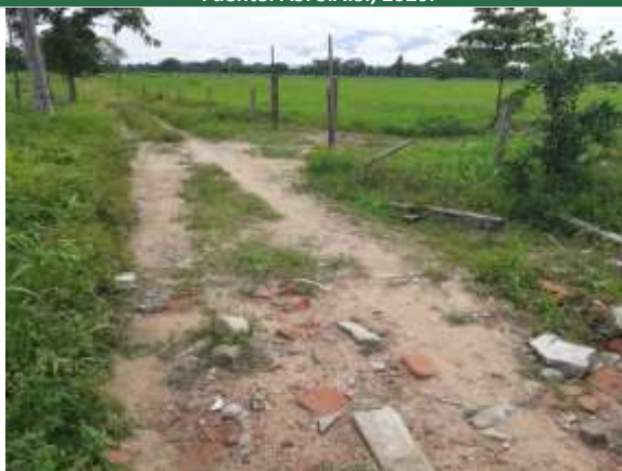
Fotografía 2.133 Estado actual vía Km 1+600 ESTE. 1066484. NORTE. 1332923 Fuente: ASI S.A.S., 2020.
