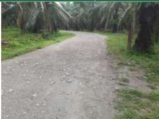
Fotografía 2.231. Estado actual vía Km 3+100 ESTE. 1066990. NORTE. 1348957. Fuente: ASI S.A.S., 2020.
