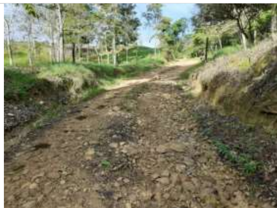
Fotografía 2.156 Estado actual vía km 1+200. ESTE. 1077558 NORTE. 1334138 Fuente: ASI S.A.S., 2020.
