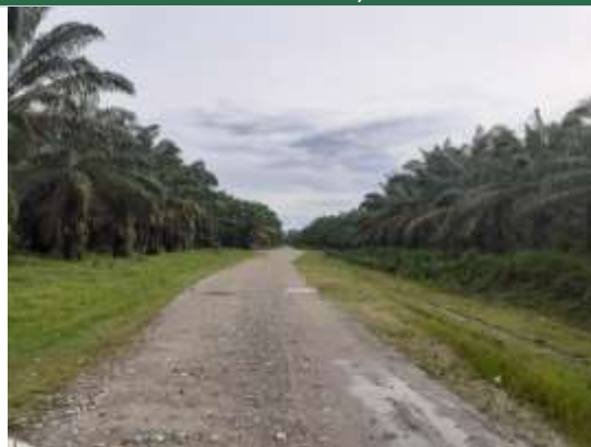
Fotografía 2.232. Fin recorrido km4+720. ESTE. 1067161. NORTE. 1350301. Fuente: ASI S.A.S., 2020.
