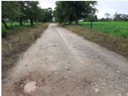
Fotografía 2.118 Estado vía actual km 5+400. ESTE. 1064901. NORTE. 1335170. Fuente: ASI S.A.S., 2020.
