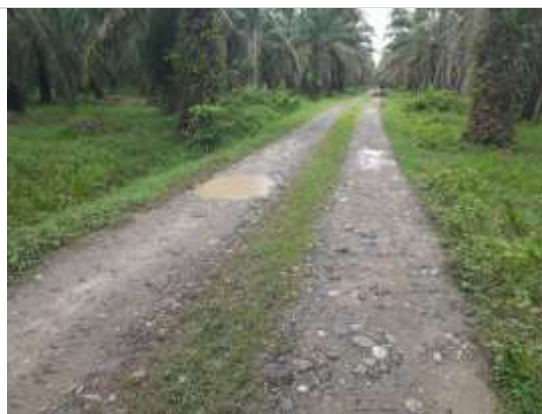
Fotografía 2.86 Estado actual Vía km 0+500. ESTE. 1068752. NORTE. 1346101.
