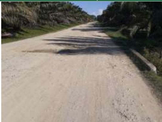
Fotografía 2.199 Estado actual vía Km 3+200 ESTE. 1063657. NORTE. 1349343. Fuente: ASI S.A.S., 2020.
