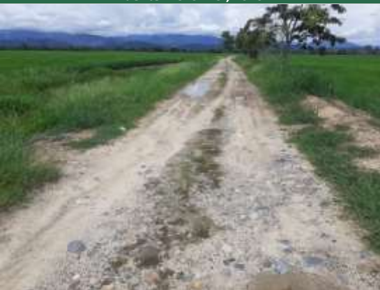
Fotografía 2.21. Estado actual vía Km 11+490 ESTE: 1068749. NORTE: 1337851. Fuente: ASI S.A.S., 2020.
