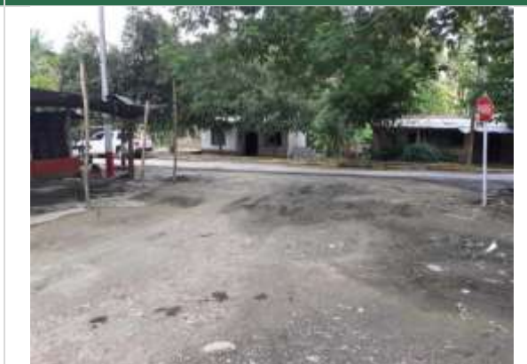
Fotografía 2.36. Fin recorrido km 2+720. ESTE. 1071298. NORTE. 1344175.
