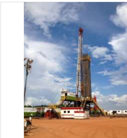
Fotografía 2.271. Taladro de perforación Fuente: ASI S.A.S., 2020.
