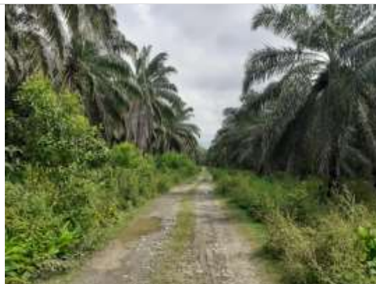
Fotografía 2.74. Estado actual vial km 2+010. ESTE. 1070095. NORTE. 1342257.
