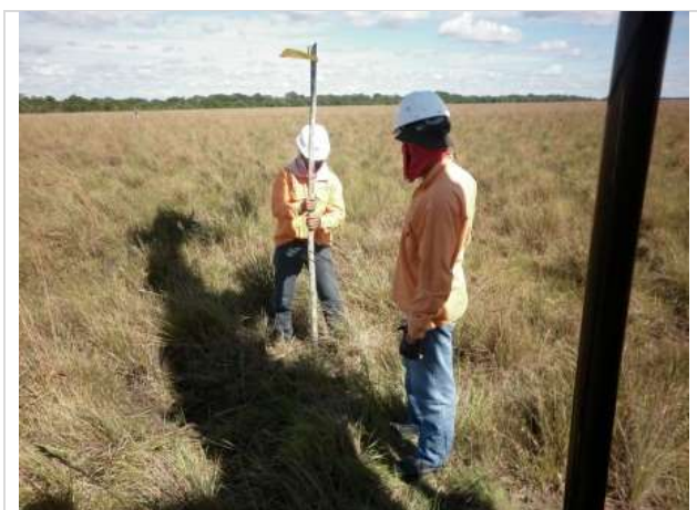
Fotografía 2.268. Localización y descapote. Fuente: ASI S.A.S., 2020.
