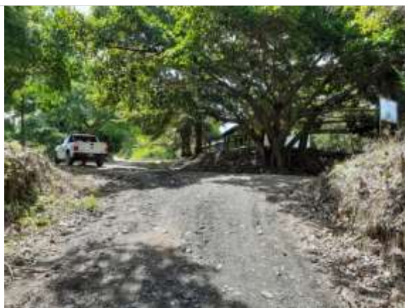
Fotografía 2.160. Municipio La Esperanza km 13+410. ESTE. 1082049. NORTE. 1327688. Fuente: ASI S.A.S., 2020.
