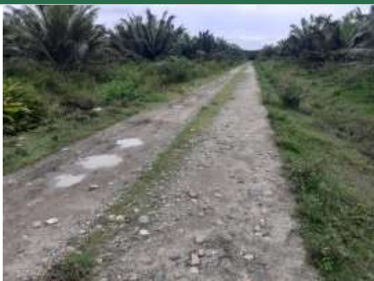
Fotografía 2.81 Estado actual vía Km 5+790 ESTE. 1065591. NORTE. 1341959.
