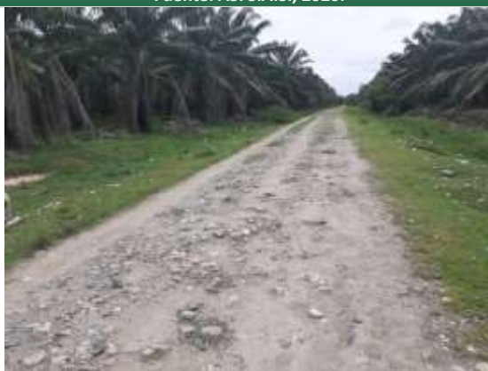
Fotografía 2.153 Estado actual vía Km 7+100 ESTE. 11073392. NORTE. 1339912 Fuente: ASI S.A.S., 2020.
