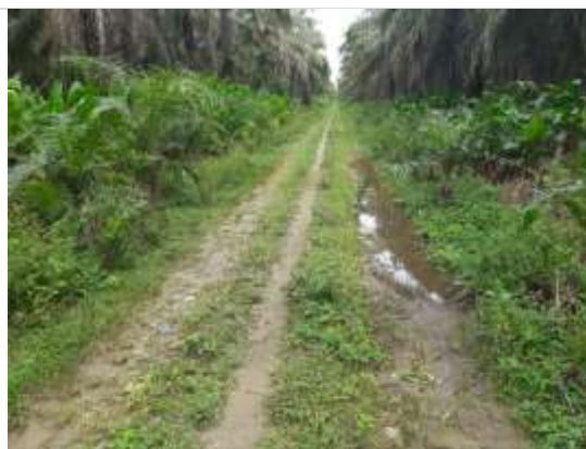
Fotografía 2.106. Estado actual vía km 0+640. ESTE. 1068227. NORTE. 1343424.
