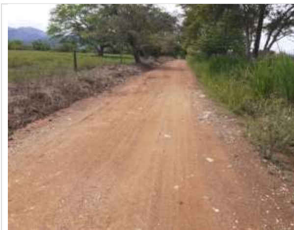
Fotografía 2.239. Estado actual vía Km 6+730 ESTE. 1074076. NORTE. 1349691. Fuente: ASI S.A.S., 2020.
