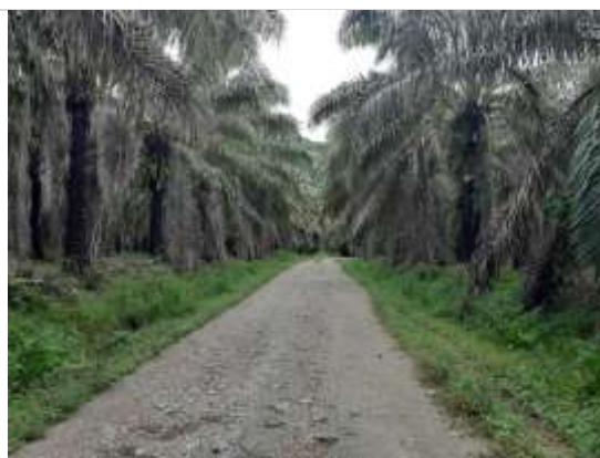
Fotografía 2.100. Estado actual vía km 1+000. ESTE. 1067750. NORTE. 1345154.
