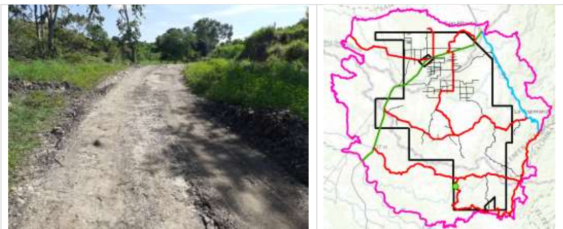
Fotografía 2.262 Estado actual vía Coordenadas: Este 1071893; Norte 1325530 Fuente: ASI S.A.S., 2020.
