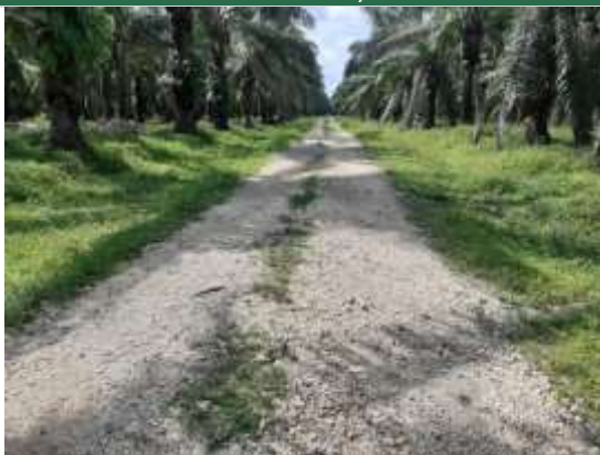
Fotografía 2.221 Estado actual vía Km 1+100 ESTE. 1065196. NORTE. 1346983. Fuente: ASI S.A.S., 2020.
