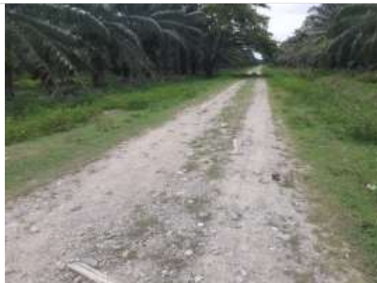
Fotografía 2.52. Estado actual vía km 1+090. ESTE. 1072356. NORTE. 1341457.
