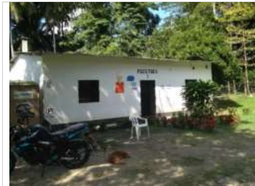
Fotografía 2.245 Área administrativa del Pozo Toca-1
