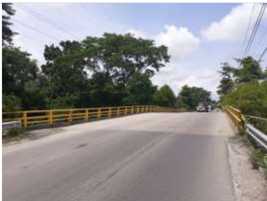
Fotografía 2.9. . Puente río San Alberto Km 0+000 ESTE. 1076100. NORTE. 1349570. Fuente: ASI S.A.S., 2020.
