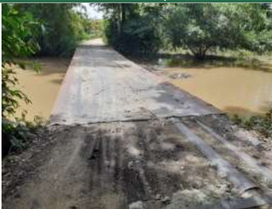
Fotografía 2.20. Puente caño oscuro km 8+420. ESTE: 1069301. NORTE: 1340526. Fuente: ASI S.A.S., 2020.
