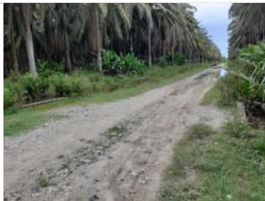
Fotografía 2.62 Estado actual Vía km 1+600. ESTE. 1069299. NORTE. 1342421.
