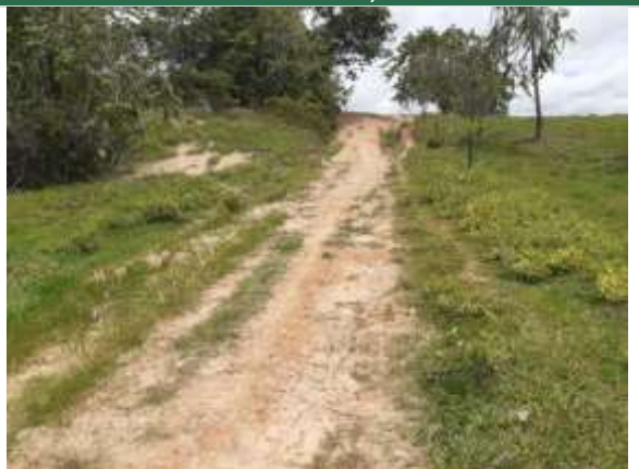
Fotografía 2.149 Estado actual vía Km 2+500 ESTE. 1072412. NORTE. 1331587 Fuente: ASI S.A.S., 2020.
