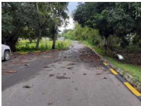
Fotografía 2.196 Fin recorrido Plan compresora gas km 4+075. ESTE. 1062793 NORTE. 1341617 Fuente: ASI S.A.S., 2020.
