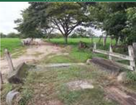
Fotografía 2.123 Queiebrapatas Km 1+600 ESTE. 1062316. NORTE. 1338210 Fuente: ASI S.A.S., 2020.
