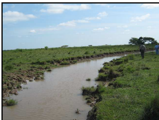
Fotografía 2.20 Canal excavado por la comunidad para drenar bajo inundable al NE AID, cerca casa Finca Bretaña.
