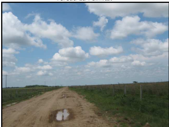
Fotografía 2.12 panorámica de la vía entre la Candelaria y La Palmita, se observa un bache asociado a las lluvias en la zona, único elemento que en este momento deteriora la vía.
