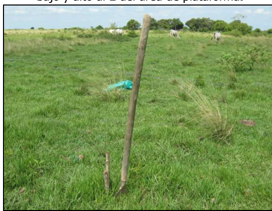
Fotografía 2.28 Materialización preliminar del sitio de perforación.
