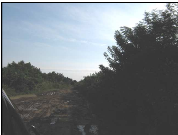
Fotografía 2.4 Aspecto general de la vía entre la Finca las Mercedes y el cruce hacia La Veremos. Sectores deteriorados de la vía.
