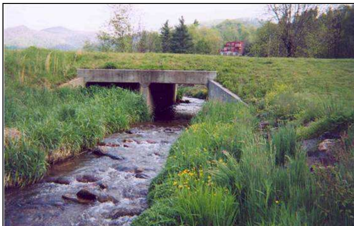
Fotografía 2.24 Otra opción para cruce de caños o manejo de aguas lluvias son los box culvert, esto dependerá del caudal que puedan llevar las aguas lluvias..
