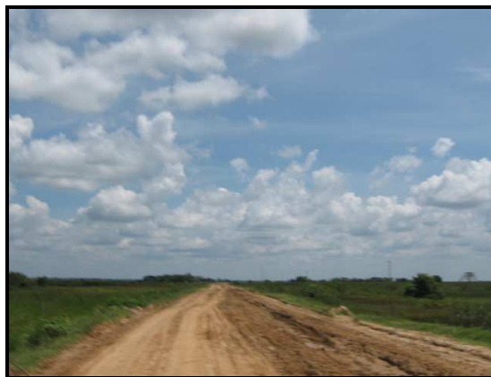
Fotografía 2.17 Aspecto general de la vía hacia montañas del Totumo.
