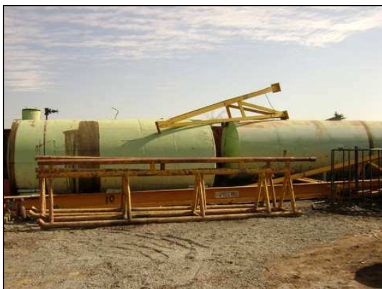
Fotografía 2.32 Tanque de combustible con dique de contención para protección ambiental
