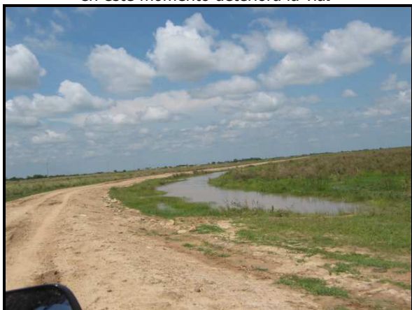
Fotografía 2.14 Vista general de la vía.
