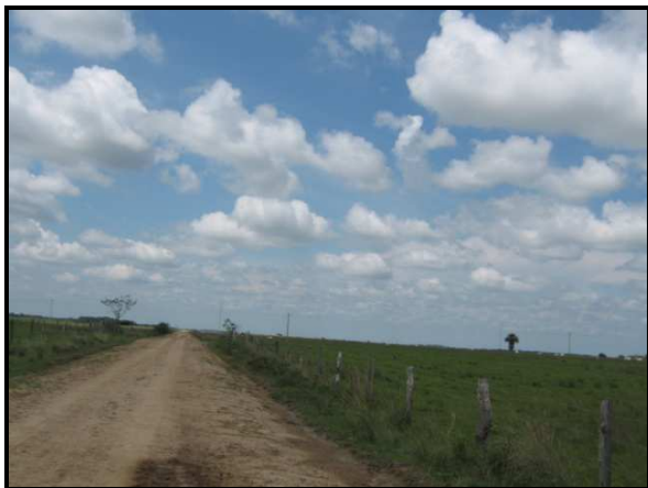
Fotografía 2.10 Otra vista del Terraplén hacia la vereda La Palmita.
