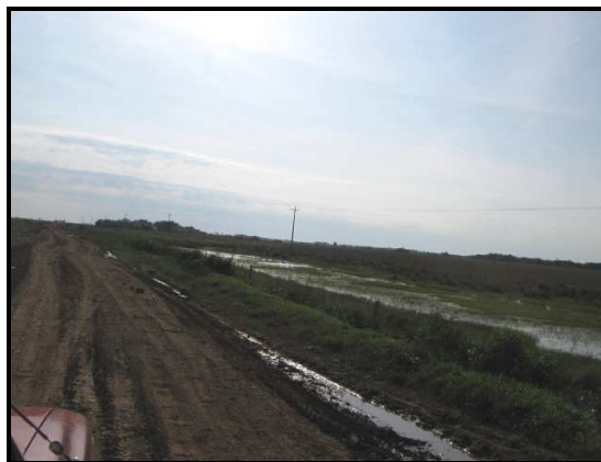
Fotografía 2.7 Todas las vías en general se han conformado con material de préstamo lateral.
