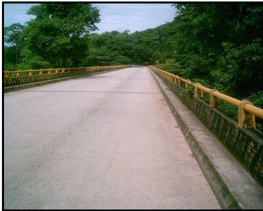
Fotografía 2.1 Puente río Tocaria
