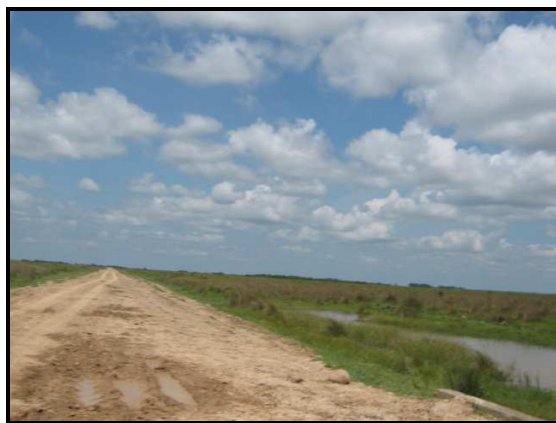
Fotografía 2.15 Formación reciente de baches sobre la vía. Sector La candelaria.
