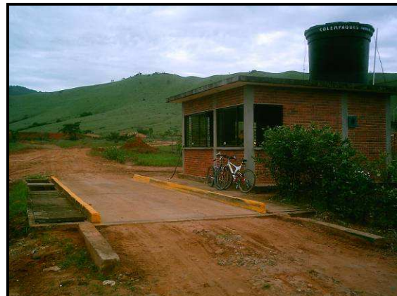
Fotografía 2.2 Báscula a la Entrada del Relleno Sanitario Macondo de El Yopal
