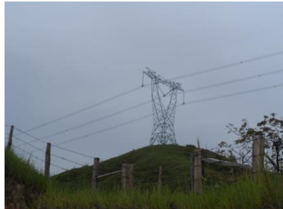
Fotografía 2- 90 Infraestructura eléctrica existente línea de alta tensión.
