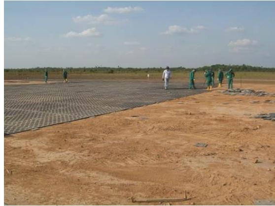
Fotografía 2- 94 Instalación de láminas Megadeck plataforma sin relleno.
