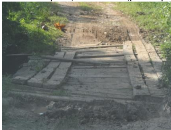
Fotografía 2- 60 Obra temporal (Puente madera), obras típicas de esta vía
