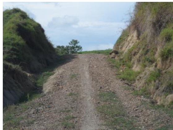
Fotografía 2- 76 Vista del estado de conformación de la vía
