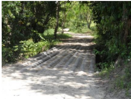
Fotografía 2- 11 Infraestructura Vial Típica vía V2 - Puente tubería petrolera.
