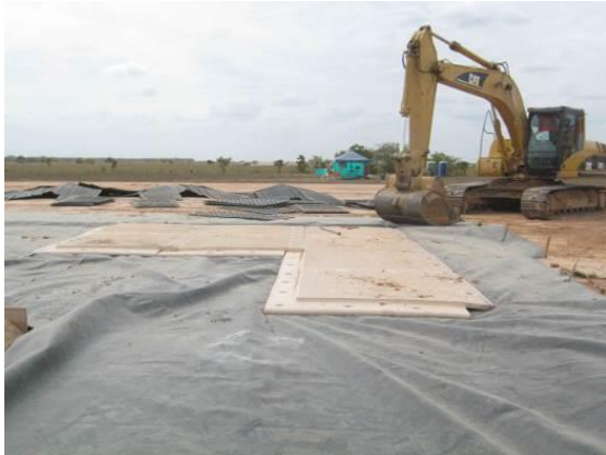
Fotografía 2- 93 Instalación de láminas Megadeck en el área de taladro
