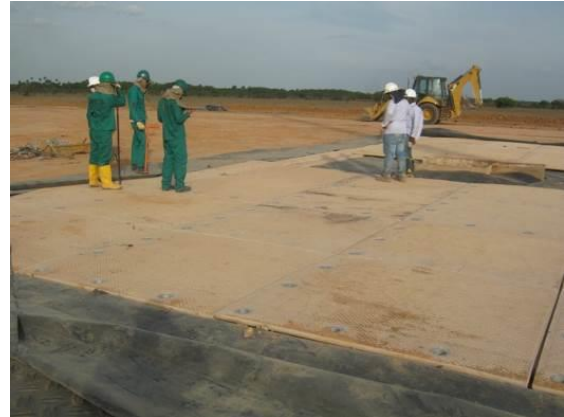
Fotografía 2- 93 Instalación de láminas Megadeck en el área de taladro
