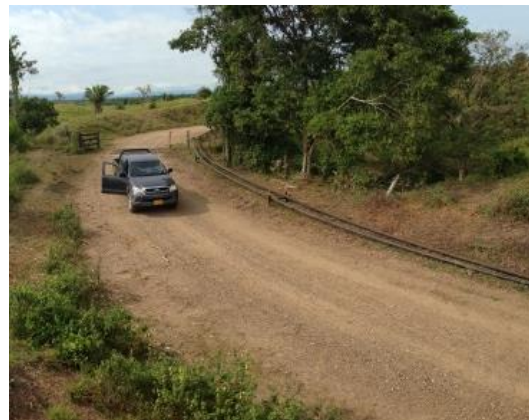
Fotografía 2- 40 Vista estado de la vía V10
