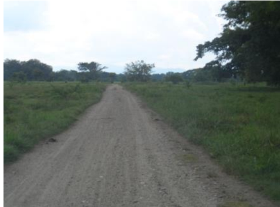
Fotografía 2- 52 Estado de la vía hacia la Hacienda Santa Fe
