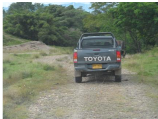
Fotografía 2- 47 Vista estado de la vía V13
