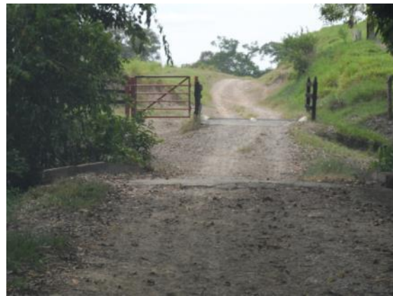
Fotografía 2- 45 Vista estado de la vía V12
