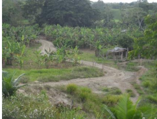
Fotografía 2- 54 Estado de la vía V16
