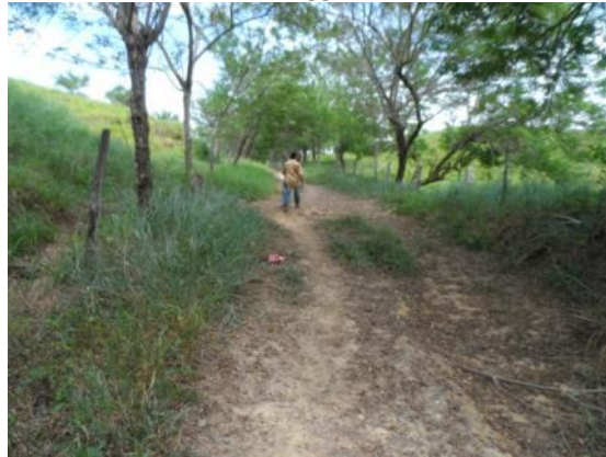
Fotografía 2- 87 Vista del estado actual de la vía V33.
