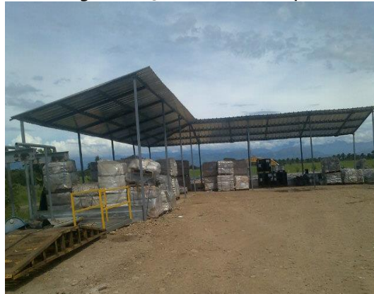
Fotografía 2- 96 Vista área de química
