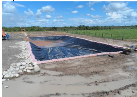
Fotografía 2- 100 Infraestructura para el manejo de cortes de perforación y ripios Bloque de Perforación Exploratoria VMM 11
