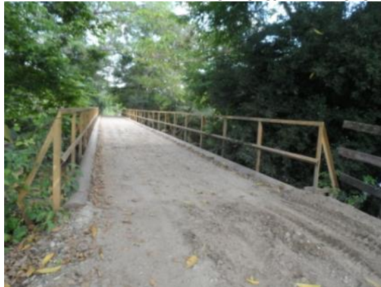
Fotografía 2- 53 Puente Rio Ermitaño Sitio de Coordenadas E: 964525; N: 1161973
