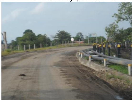
Fotografía 2- 88 Vista líneas de flujo paralelas a las vías de acceso.
