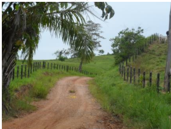
Fotografía 2- 65 Vista estado de conformación de la vía V21
