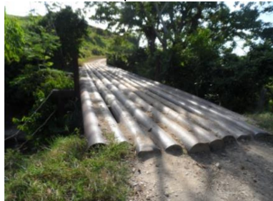
Fotografía 2- 22 Puente en tubería petrolera, obras típicas en la vía
