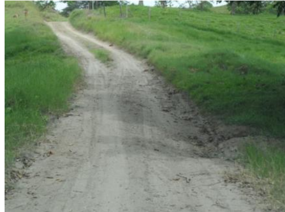
Fotografía 2- 43 Vista estado de la vía V11
