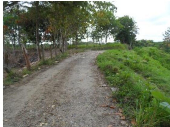
Fotografía 2- 38 Vista estado de la vía V9
