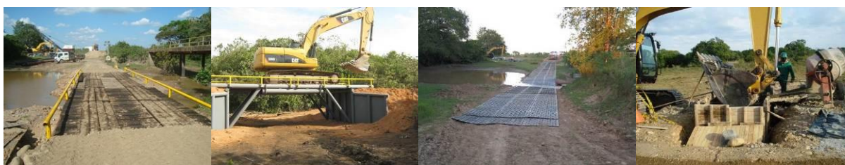
Instalación de Parrillas
