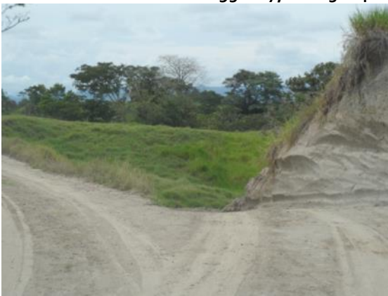
Fotografía 2- 44 Sitio de inicio de la vía V11 (Acceso Finca Los Alpes) Sitio de Coordenadas E: 958627; N: 1158648
