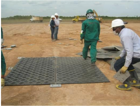
Fotografía 2- 94 Instalación de láminas Megadeck plataforma sin relleno.
