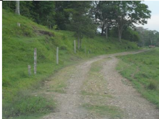
Fotografía 2- 67 Vista estado de conformación de la vía V22
