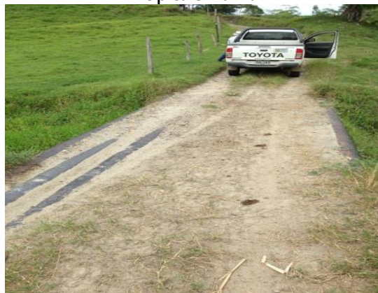
Fotografía 2- 66 Puente tubería petrolera obra típica en la vía
