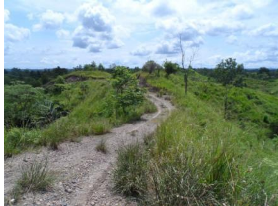
Fotografía 2- 86 Vista del estado actual de la vía V32.
