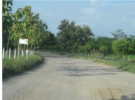
Fotografía 2- 36 Vista estado de la vía V8
