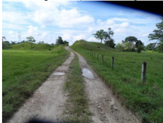
Fotografía 2- 84 Vista de la vía 31
