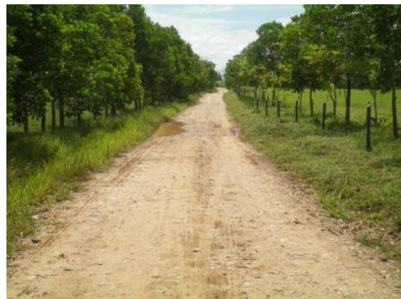
Fotografía 2- 18 Vista estado de la vía V4 Sitio de Coordenadas E:961789 N:1192935
