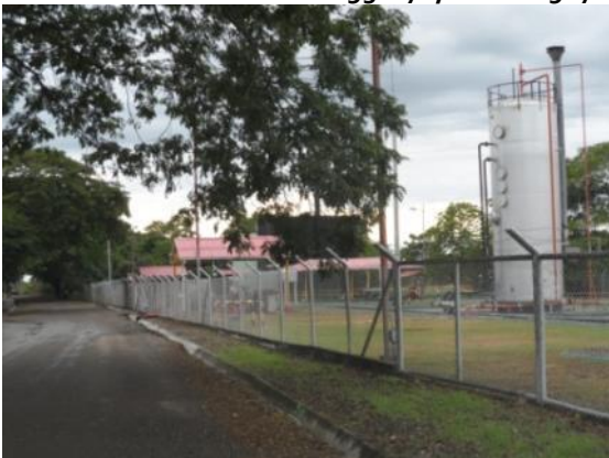
Fotografía 2- 7 Infraestructura petrolera a la margen derecha de la vía (Campo Palagua) Sitio de Coordenadas E: 951272, N: 1166987
