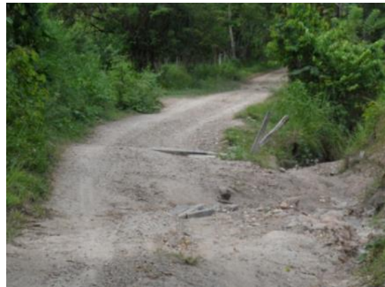
Fotografía 2- 27 Vista estado de conformación de la vía V6
