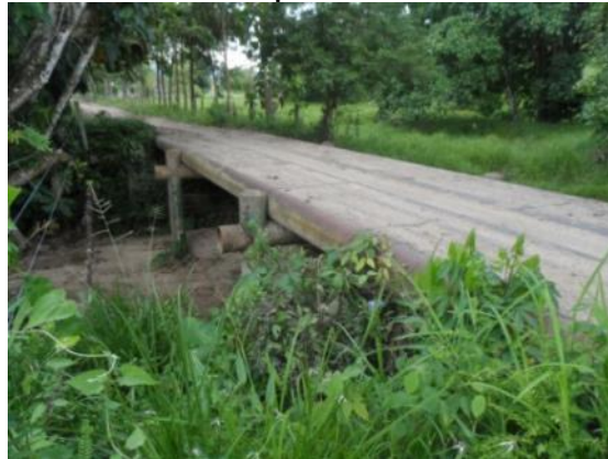
Fotografía 2- 79 Puente tubería petrolera, obras típicas en la vía
