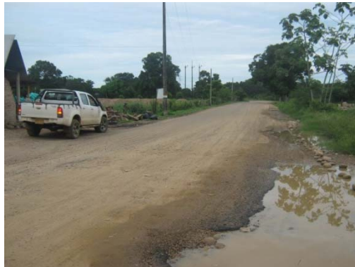
Fotografía 2.1. Salida del casco urbano del municipio de Maní
