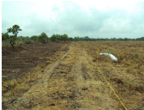
Fotografía 2.33. Se observan las estacas y el alineamiento de un tramo de vía en el que se ejecuta el descapote
