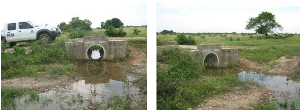
Fotografía 2.32. Alcantarilla típica en las vías del área de interés Llanos 26
