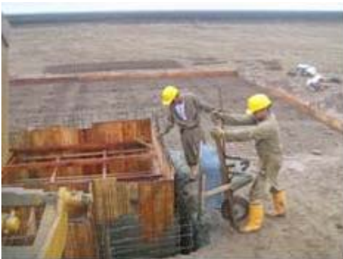
Fotografía 2.45. Fundida de ambas estructuras monolíticamente
