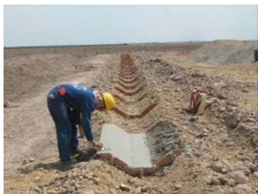
Fotografía 2.51. Instalación de las guías de las cunetas trapezoidales
