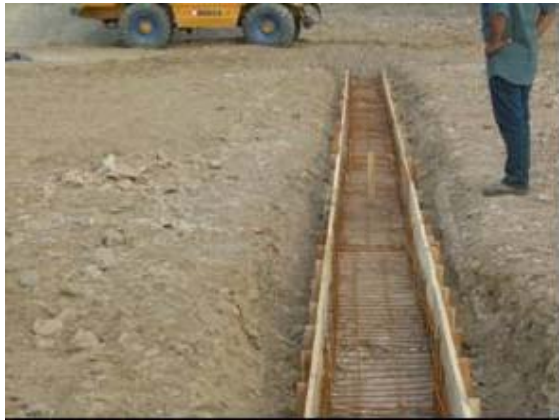
Fotografía 2.53. Instalación de formaleta y malla de refuerzo
