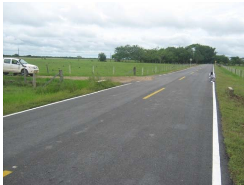
Fotografía 2.19. Inicio de tramo pavimentado de la vía descrita.
