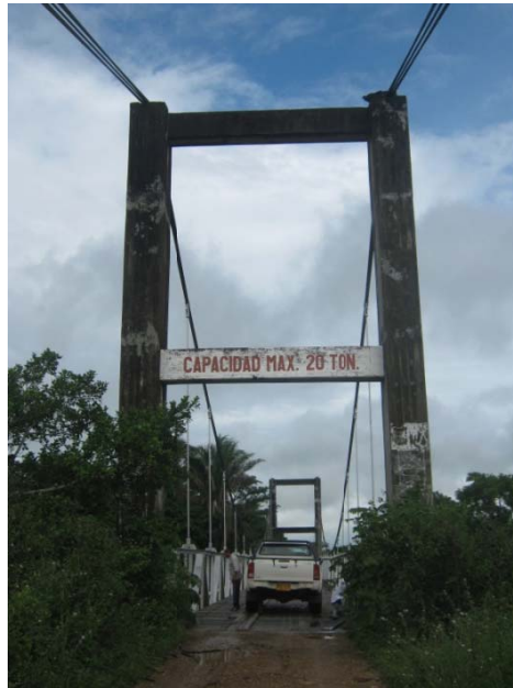
Fotografía 2. 14. Se observa una camioneta de platón 4*4 que cruza el puente con solo 70 cm a cada lado de espacio libre
