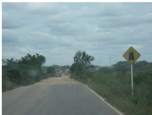
Fotografía 2.3. Fin del tramo pavimentado. Se inicia tramo destapado en buenas condiciones
