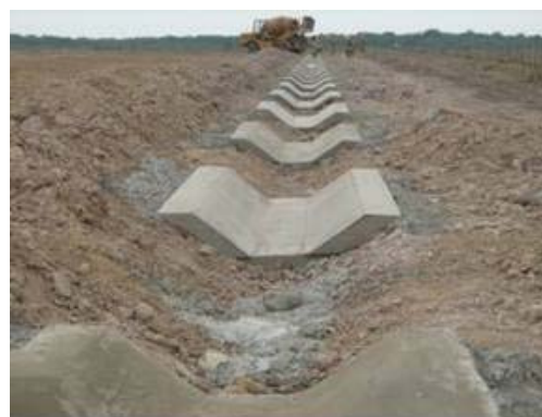
Fotografía 2.52. Fundido en ajedrez de tramos de 2.5 m
