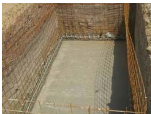
Fotografía 2.47. Instalación de la malla de refuerzo
