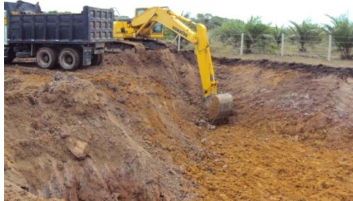
Fotografía 2.40. Corte de préstamo lateral típico en una locación.
