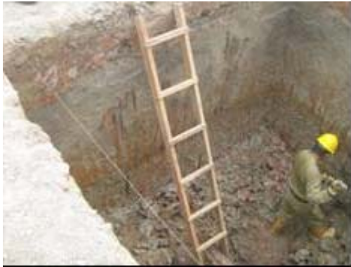
Fotografía 2.43. Excavación mecánica y posterior perfilado manual del cellar
