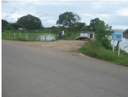
Fotografía 2.22. Cruce sobre la vía principal donde inicia el tramo de vía descrito
