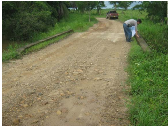
Fotografía 2.29. Cruce caño Guarimena por pontón en concreto.
