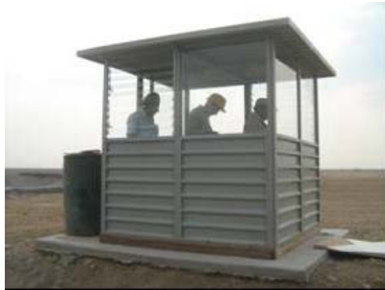
Fotografía 2.55. Caseta de celaduría prefabricada sobre placa de concreto reforzado
