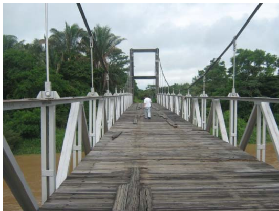
Fotografía 2. 13. Se aprecia el ancho de 4.5 m del puente sobre el Río Unete.
