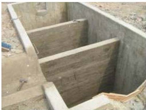
Fotografía 2.49. Estructura una vez terminada.
