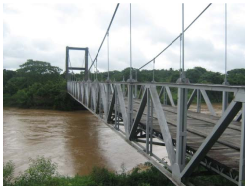
Fotografía 2.17. Cruce sobre río Unete por puente en estructura metálica en buenas condiciones
