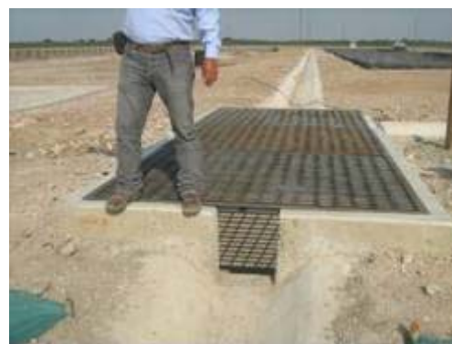
Fotografía 2.50. Rejilla de protección de la estructura.
