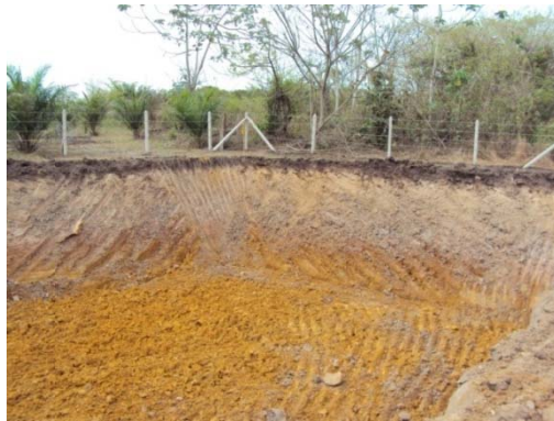
Fotografía 2.41. Se observan las dimensiones y el acabado de la excavación de préstamo lateral.
