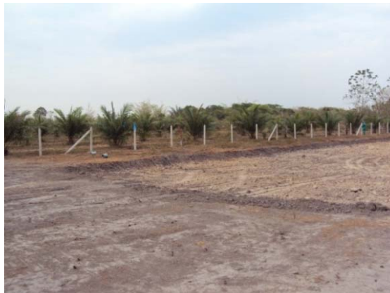
Fotografía 2.39. Se observa una locación tipo sobre la cual ya se ha realizado el descapote.
