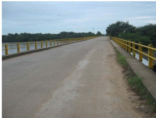
Fotografía 2.2. Cruce del Río Cusiana por puente en concreto apto para el cruce de cualquier vehículo.
