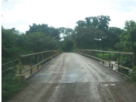
Fotografía 2.27. Cruce de Río Charte por puente en estructura metálica.
