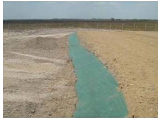
Fotografía 2.59. Tramo del material instalado sobre talud de un terraplén.
