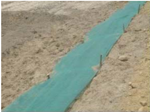
Fotografía 2.58. Detalle de las estacas de madera fijando el geomatrix al suelo
