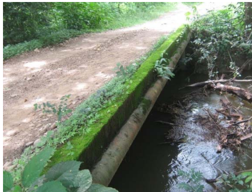
Fotografía 2.11. Cruce de Caño Saboa sobre pontón soportado por tubería metálica.
