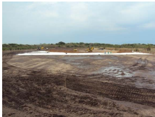
Fotografía 2.42. Se puede observar el conjunto de actividades ejecutadas en la conformación de terraplén en una locación tipo.
