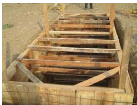
Fotografía 2.48. Instalación de formaleta
