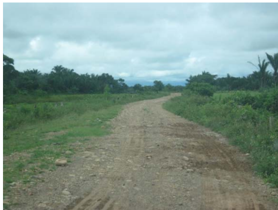
Fotografía 2.28. Tramo de vía. Se observa la banca conformada con material granular en buen estado.
