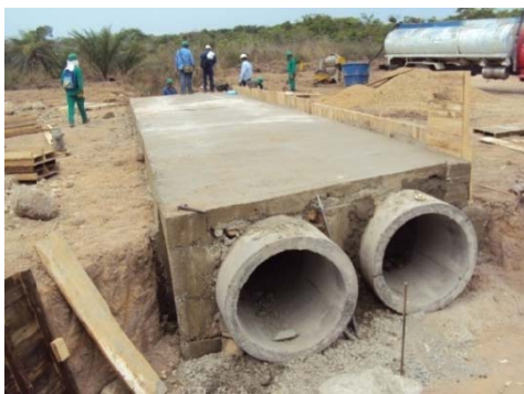
Fotografía 2.37. Construcción de alcantarilla doble de 36'' en sitio que drena aguas de escorrentía en invierno.
