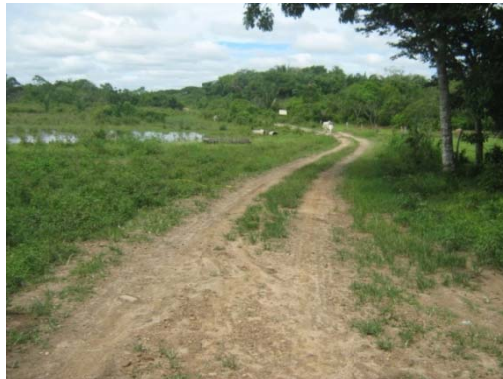
Fotografía 2.31. Continuación de vía (Tramo 3) en el sector de la finca Las Delicias en el centro del Bloque.
