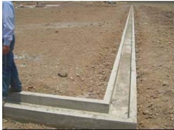
Fotografía 2.54. Cárcamo una vez desencofrado.
