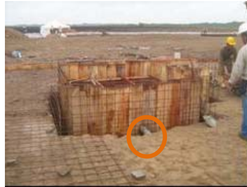
Fotografía 2.44. Instalación de formaleta y refuerzo metálico de cellar y placa para fundir monolíticamente.
