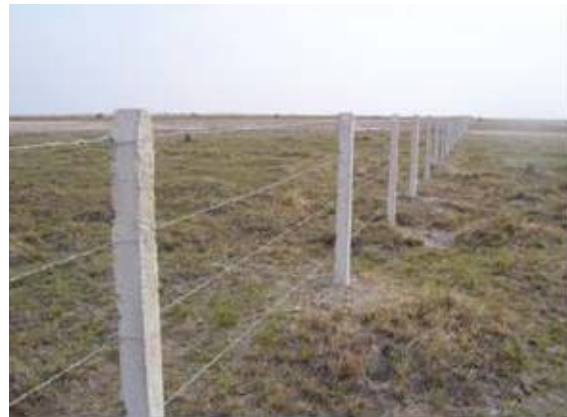
Fotografía 2.57. Cerco una vez instalados los 4 hilos de alambre de púa
