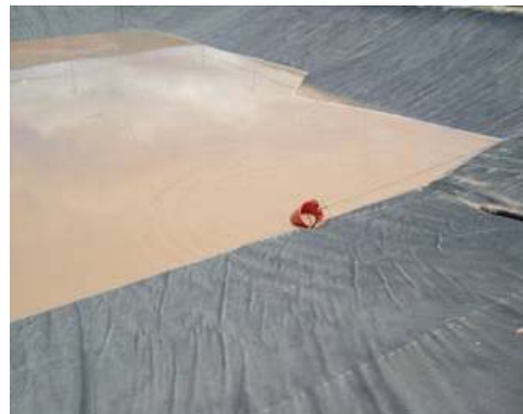
Fotografía 2.68 Piscina de almacenamiento de cortes de perforación.
