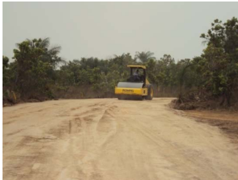
Fotografía 2.34. Luego de la disposición y extensión del material que se utilizará para la nivelación de la vía, se procede a su compactación.
