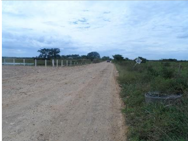
Fotografía 2-3 Inicio de la vía V1 Coordenadas: E:1283424 N:1125008
