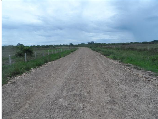
Fotografía 2-4 vista de la vía V2 Coordenadas E:1285322 , N:1127434
