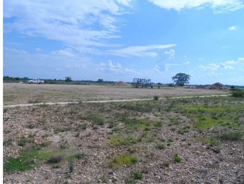
Fotografía 2-7 Estado de la vía V5 Coordenadas E: 1297083, N: 1128588
