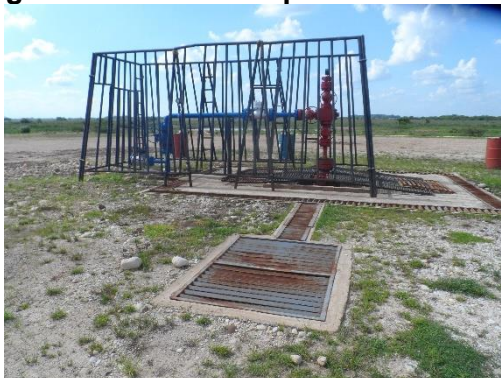
Fotografía 2-12 Pozo Exploratorio Berbena-1
