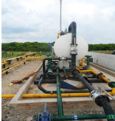
Fotografía 2-20 Separador trifásico
