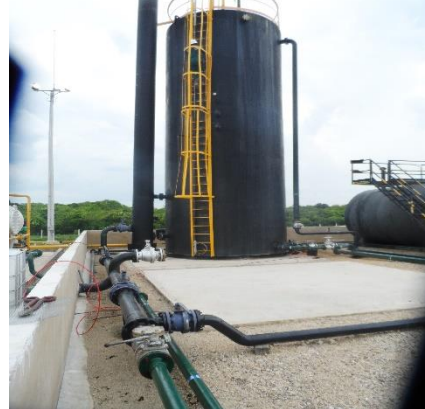
Fotografía 2-21 Gauge Tank
