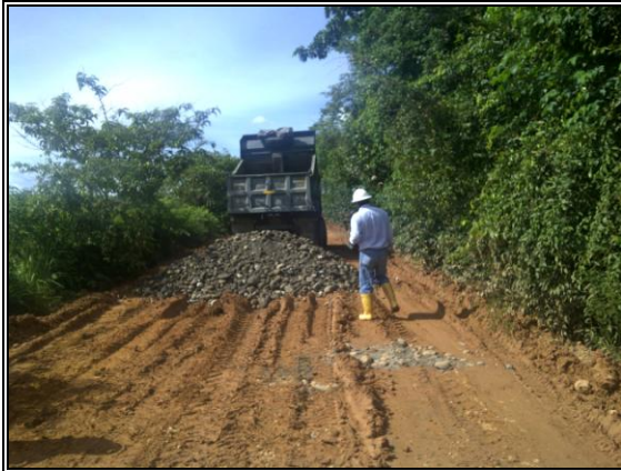
a. Disposición de material de reafirmado.
