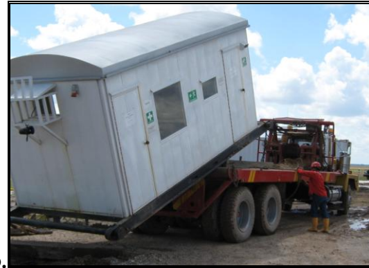
Fotografía 2- 59: Instalación de un contenedor oficina y laboratorio tipo.
