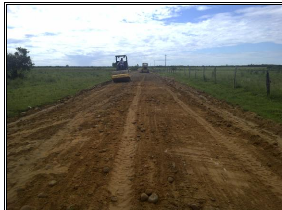
c. y d. Compactación con vibrocompactador de rodillo.
