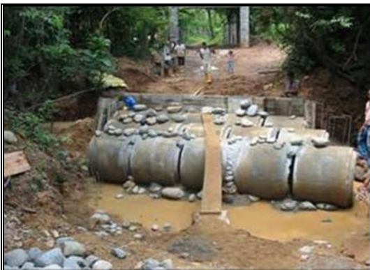
Fotografía 2- 31: Tubería de 36" de diámetro atracadas en concreto.
