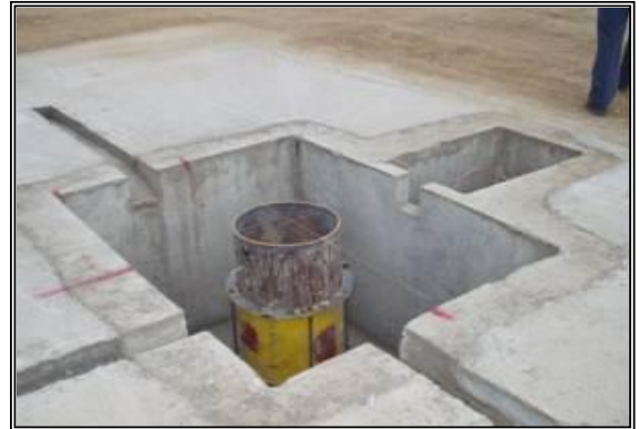
Fotografía 2- 37: Obras típicas de construcción de contrapozo y plataforma.
