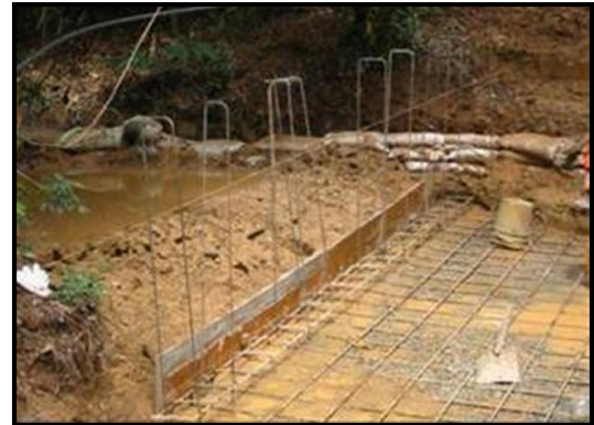
Fotografía 2- 30: Excavación de fondo y arme de la estructura para la fundición de la placa de fondo.
