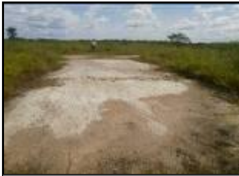
Fotografía 2- 13: Placa de concreto al interior de la locación de los pozos Zafiro-1 y Calcedonia-1.
