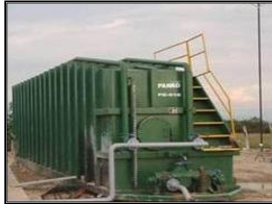
Fotografía 2- 63: Tanque de almacenamiento tipo Frac Tank.
