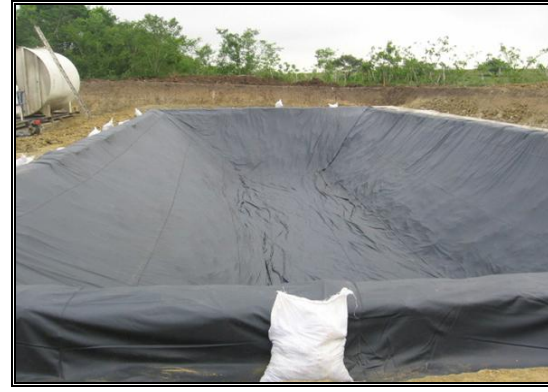
Fotografía 2- 44: Instalación de geomembrana para la protección de suelos.
