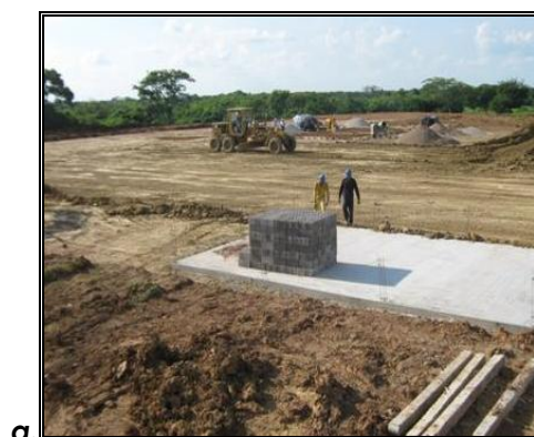
Fotografía 2- 38: Obras típicas de construcción de la placa del taladro.
