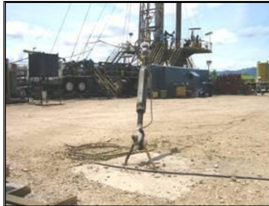
Fotografía 2- 49: Anclajes del equipo de perforación.
