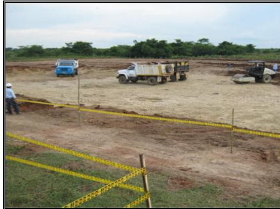
Fotografía 2- 35: Nivelación del área de la plataforma.
