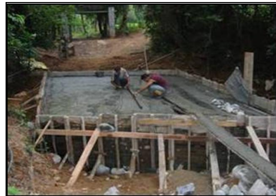
Fotografía 2- 32: Placa de rodadura en concreto de 3000 Psi reforzado.
