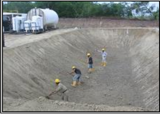
Fotografía 2- 43: Obras típicas para la construcción de piscinas de tratamiento.
