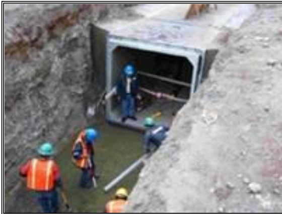
Fotografía 2- 33: Representación del proceso constructivo de un Box Couvert .
