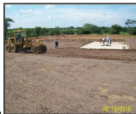
Fotografía 2- 38: Obras típicas de construcción de la placa del taladro.
