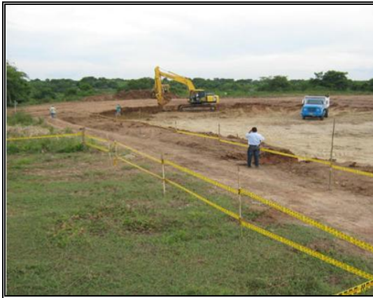
Fotografía 2- 34: Conformación de terraplenes.
