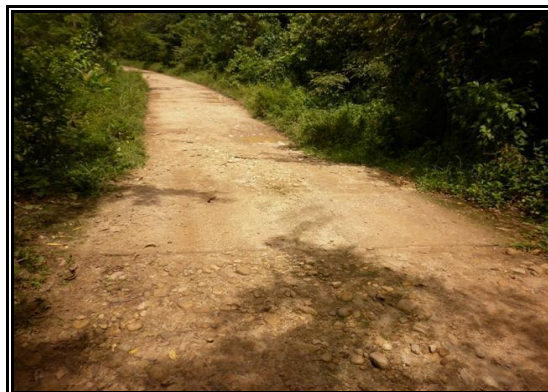
Fotografía 2- 1: Estado de la vía, costado nororiental del Bloque LLA 40, vereda La Unión Candelaria Alta, municipio de Paz de Ariporo.
