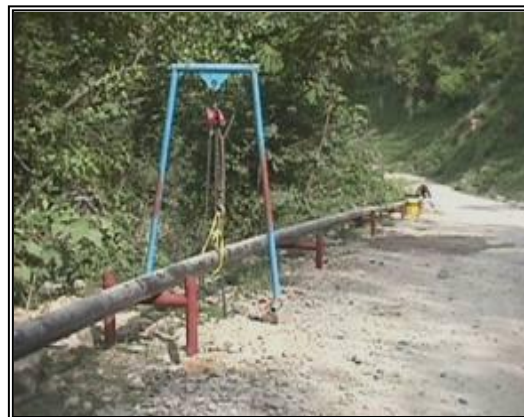
Fotografía 2- 74: Grúa y tendido de marcos "H".
