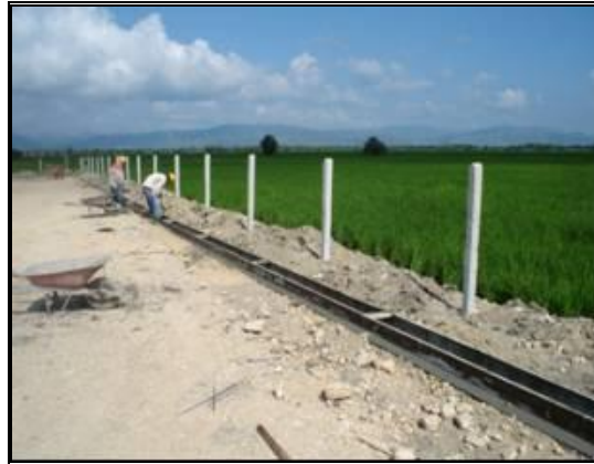
Fotografía 2- 42: Obra típica de cunetas perimetrales para aguas lluvias.
