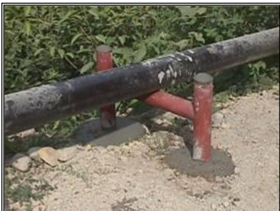
Fotografía 2- 73: Equipo para sostener la tubería (marcos H).
