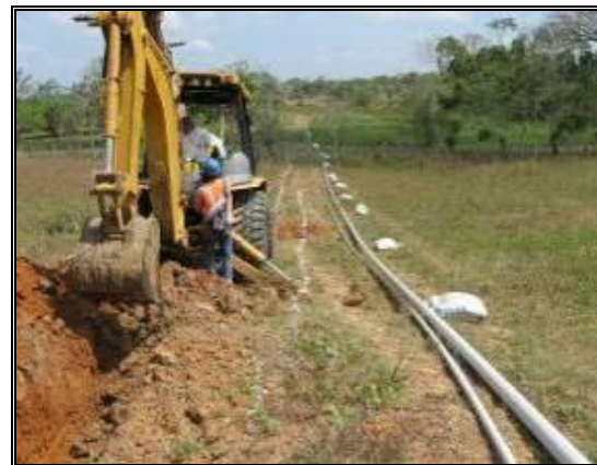
Fotografía 2- 67: Tendido típico de una línea de flujo.
