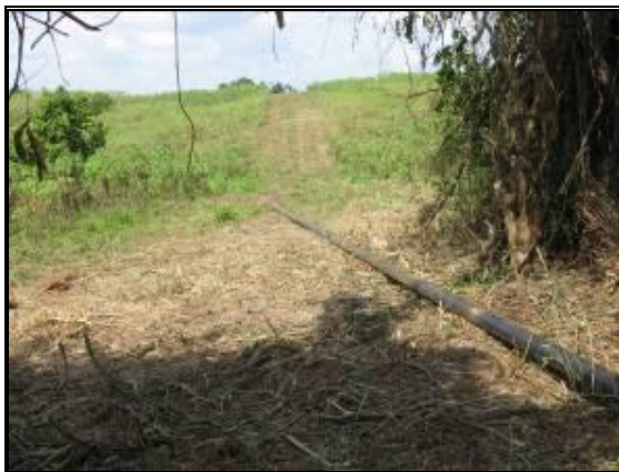
Fotografía 2- 67: Tendido típico de una línea de flujo.
