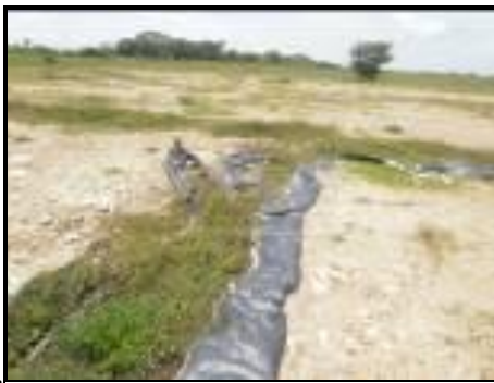
Fotografía 2- 17: Infraestructura existente en la locación del pozo Puinaves-2. a. Skimmer; b. Canales en tierra recubiertos con geomembrana; c. Piscinas de tratamiento de aguas y lodos de perforación.
