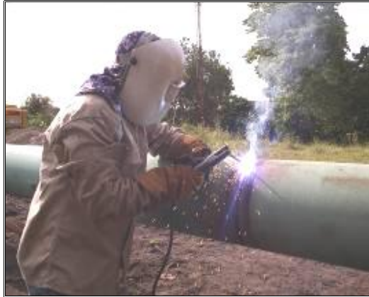
Fotografía 2- 69: Soldadura de juntas.
