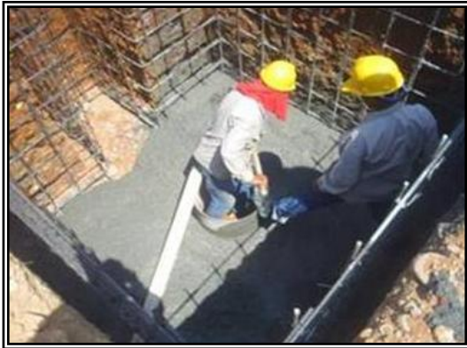
Fotografía 2- 37: Obras típicas de construcción de contrapozo y plataforma.
