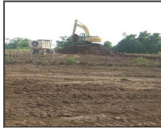
Fotografía 2- 34: Conformación de terraplenes.
