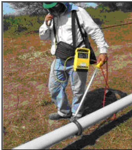
Fotografía 2- 72: Inspección del revestimiento de la tubería, detección de puntos de falla.
