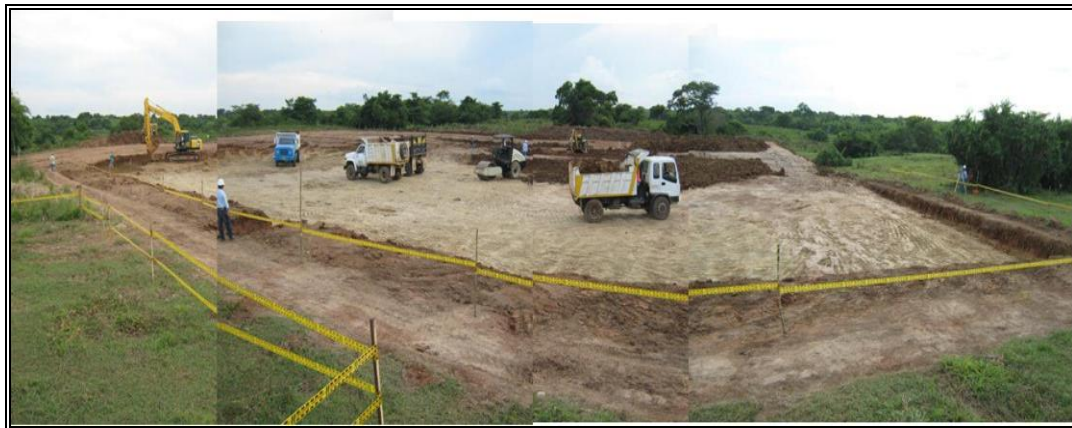
Fotografía 2- 48: Vías internas en la locación.
