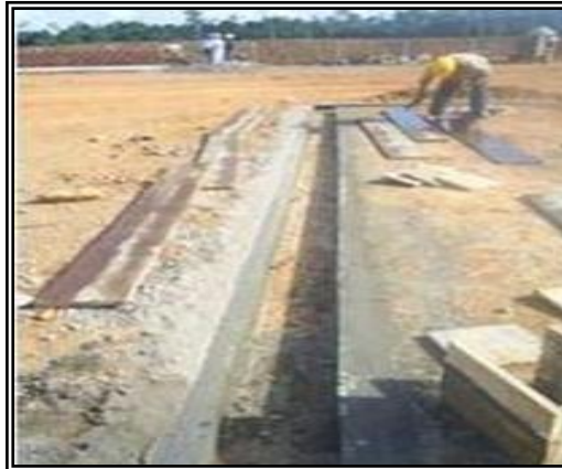
Fotografía 2- 41: Obra típica de cunetas perimetrales en áreas operacionales.
