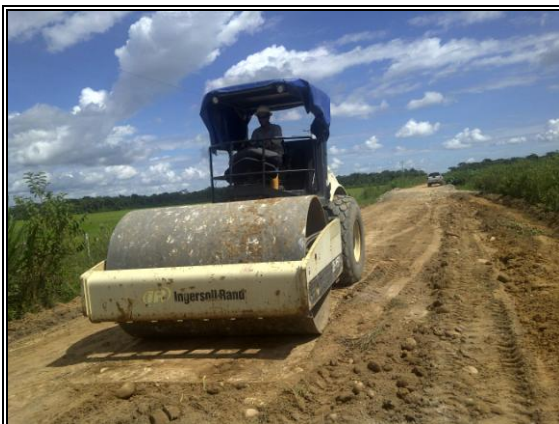
c. y d. Compactación con vibrocompactador de rodillo.
