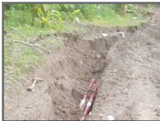
Fotografía 2- 75: Instalación de tubería enterrada.
