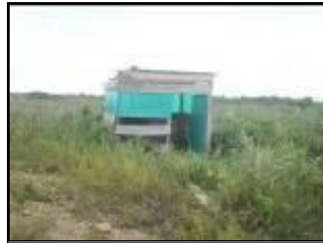
Fotografía 2- 14: Caseta de almacenamiento en la plataforma de perforación.
