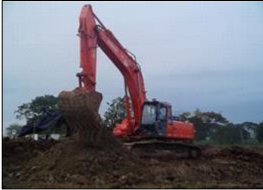
Fotografía 2-18: Excavaciones y rellenos para la conformación de una plataforma multipozo.
