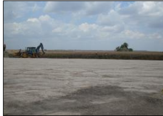
Fotografía 2-20: Compactación de capas de afirmado.
