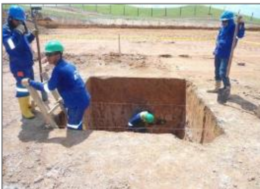
Fotografía 2-32: Obras típicas de construcción de contraozo.
