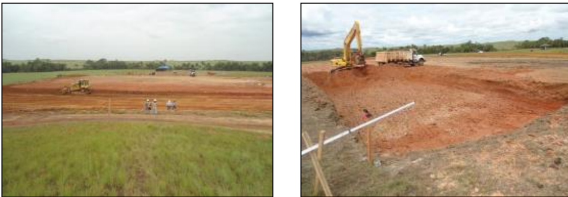
Fotografía 2-17: Limpieza y descapote para la construcción de una plataforma multipozo.
