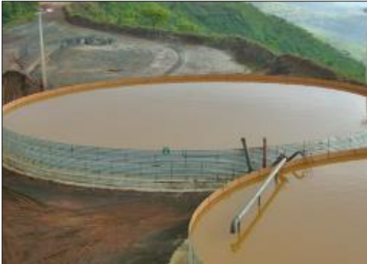
Fotografía 2-39: Tanques australianos y tanques tipo frac tank.
