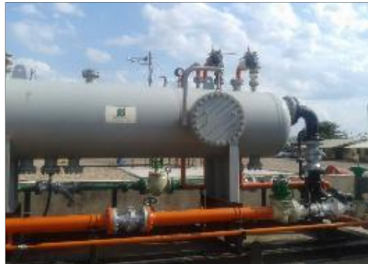
Fotografía 2-83: Separador master y separador de prueba.
