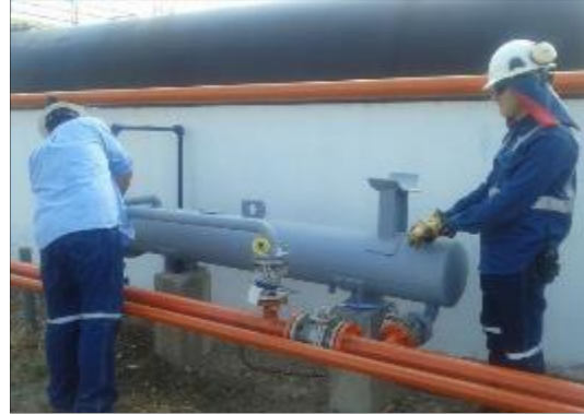
Fotografía 2-84: Intercambiador y Aero-enfriador.
