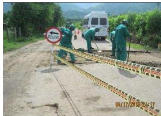
Fotografía 2-66: Cruce de vía tipo por la construcción de una línea de flujo.
