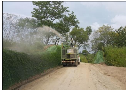
Fotografía 2-16: Revegetalización de taludes.
