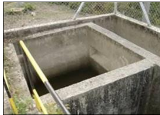
Fotografía 2-24: Obras típicas de construcción de una trampa de grasas.
