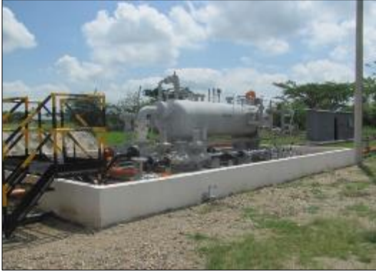
Fotografía 2-77: Separador trifásico horizontal.
