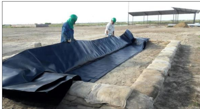
Fotografía 2-38: Diques para equipos auxiliares.
