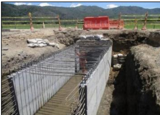
Fotografía 2-13: Proceso constructivo de un box culvert en una vía de acceso.
