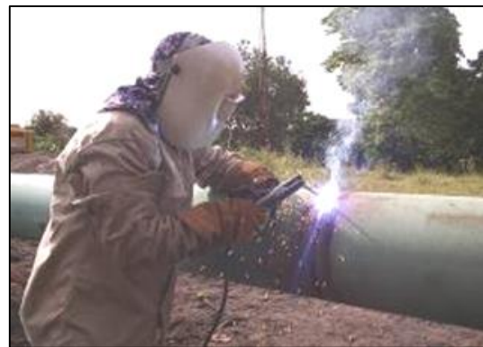
Fotografía 2-71: Soldadura de juntas.
