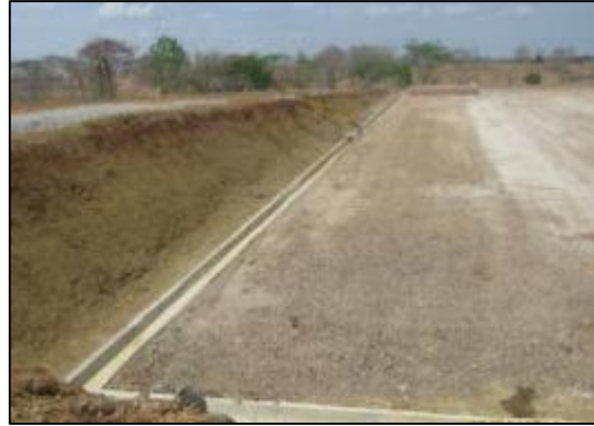
Fotografía 2-19: Taludes típicos de una plataforma multipozo.
