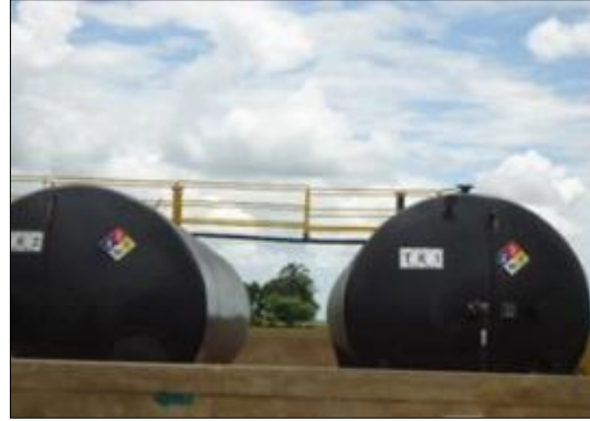
Fotografía 2-78: Tanque de almacenamiento en dique confinado.
