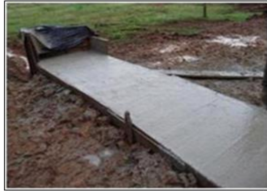
Fotografía 2-12: Proceso constructivo de una alcantarilla en una vía de acceso.
