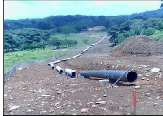
Fotografía 2-69: Tendido típico de una línea de flujo.
