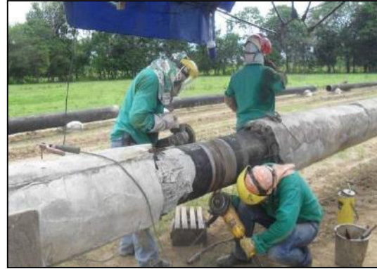
Fotografía 2-70: Doblado y soldadura de juntas.
