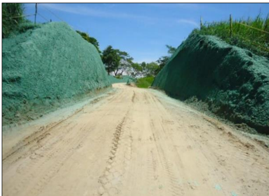
Fotografía 2-16: Revegetalización de taludes.
