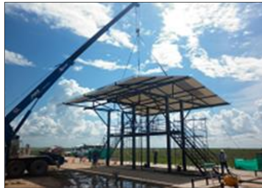
Fotografía 2-59: Proceso constructivo del cargadero de crudo.
