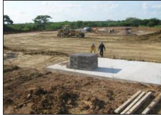
Fotografía 2-31: Alistado para la construcción de la placa de concreto del taladro.
