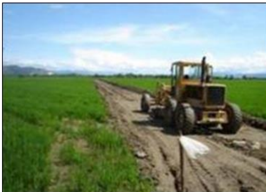
Fotografía 2-9: Descapote de un acceso vial.
