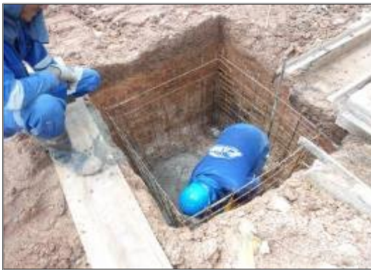
Fotografía 2-24: Obras típicas de construcción de una trampa de grasas.
