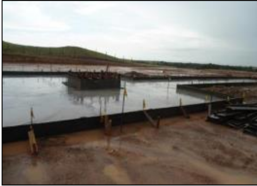
Fotografía 2-31: Alistado para la construcción de la placa de concreto del taladro.
