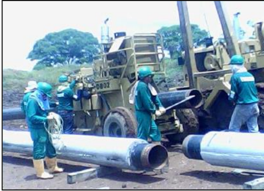
Fotografía 2-70: Doblado y soldadura de juntas.
