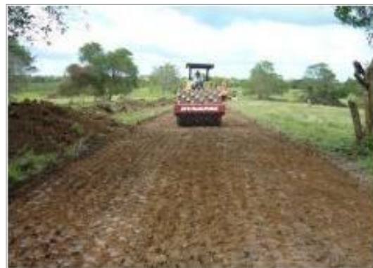
Fotografía 2-9: Descapote de un acceso vial.
