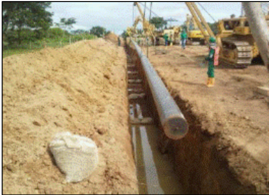
Fotografía 2-75: Vereda del revestimiento de la tubería. Detección de puntos de falla.
