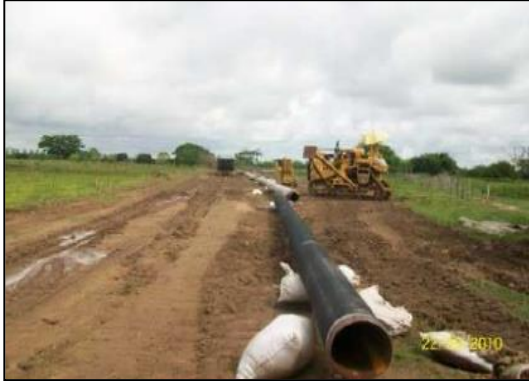
Fotografía 2-69: Tendido típico de una línea de flujo.
