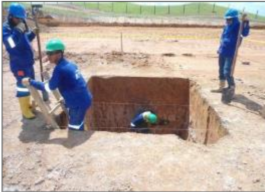
Fotografía 2-40: Obras típicas de construcción de contrapozo.
