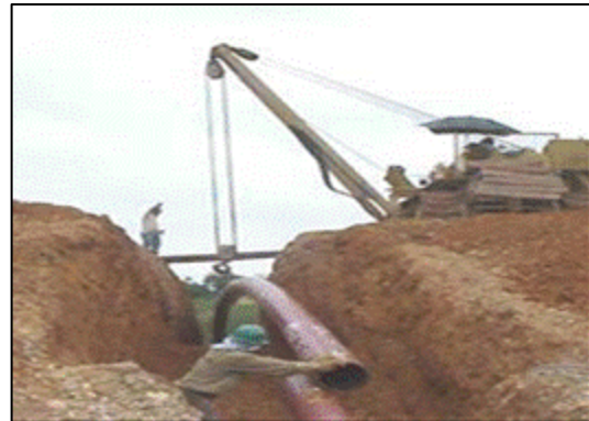
Fotografía 2-85: Vereda del revestimiento de la tubería. Detección de puntos de falla.
