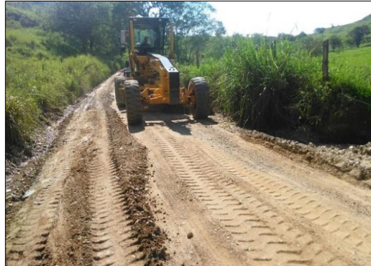
*Fotografía 2-15: Nivelación de la subrasante y cuneteo.
