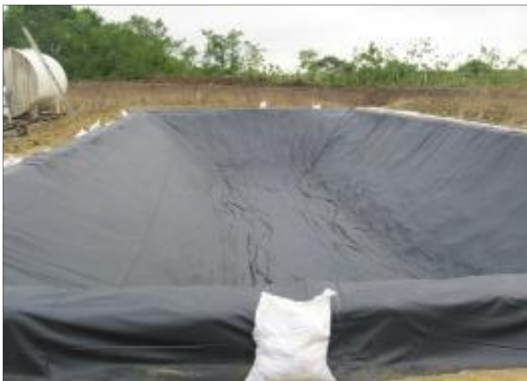
Fotografía 2-42: Instalación de la geomembrana para la construcción de piscinas.
