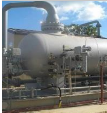
Fotografía 2-67: Separador trifásico.
