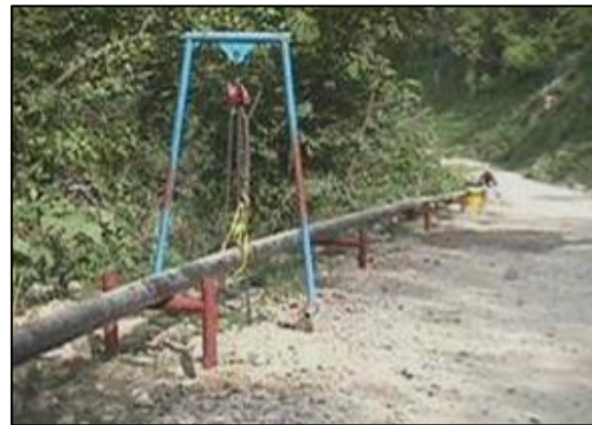
Fotografía 2-73: Grúa y tendido de marcos "H".
