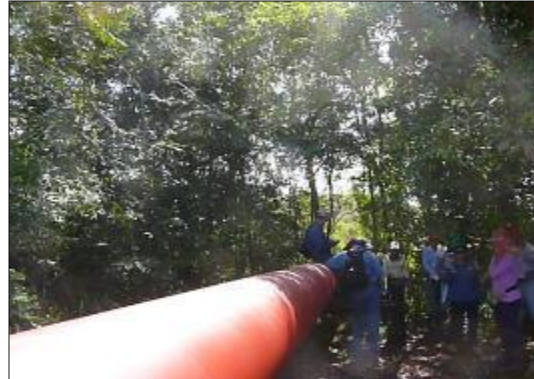
Fotografía 2-75: Lingada de tubería en marcos “H” en cobertura de vegetación secundaria, sin la tala de vegetación durante su construcción.
