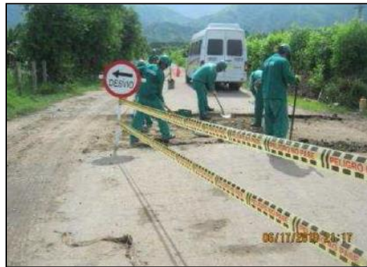
Fotografía 2-76: Cruce de vía tipo por la construcción de una línea de flujo.
