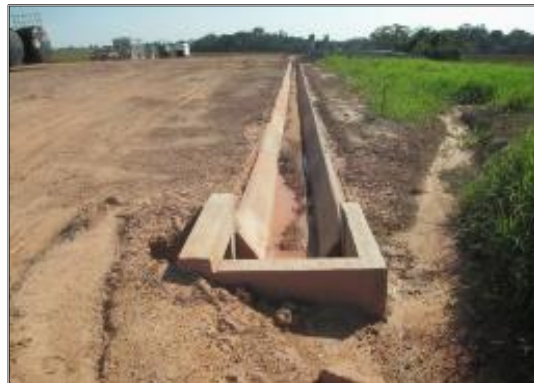
Fotografía 2-36: Construcción cunetas perimetrales en concreto.
