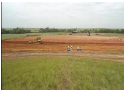
Fotografía 2-25: Limpieza y descapote para la construcción de una plataforma multipozo.
