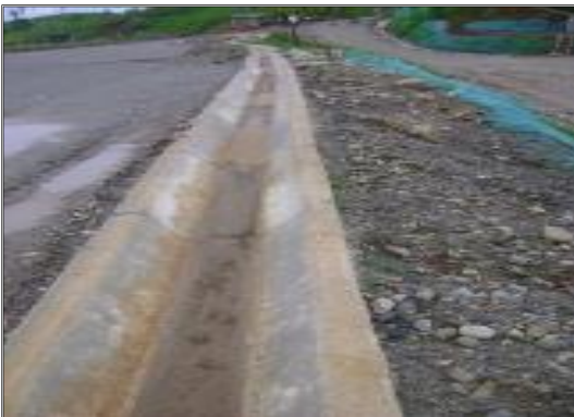
Fotografía 2-33: Cunetas de aguas lluvias terminada en sacos rellenos suelo-cemento.
