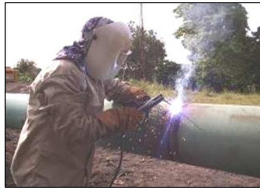
Fotografía 2-81: Soldadura de juntas.
