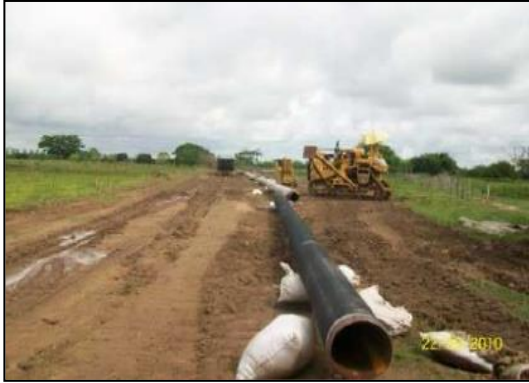
Fotografía 2-79: Tendido típico de una línea de flujo.
