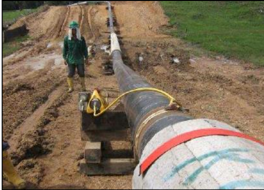
Fotografía 2-82: Prueba radiográfica, toma de placas.
