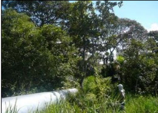
Fotografía 2-74: Lingada de tubería en marcos “H” en cobertura de bosque de galería y/o ripario, sin la tala de vegetación durante su construcción.
