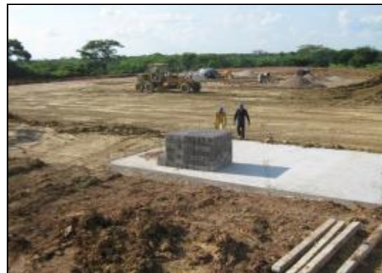
Fotografía 2-39: Alistado para la construcción de la placa de concreto del taladro.
