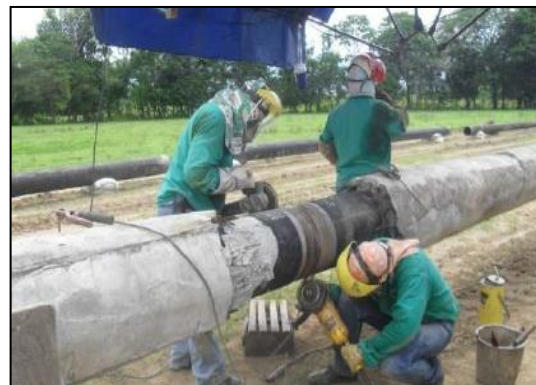
Fotografía 2-80: Doblado y soldadura de juntas.
