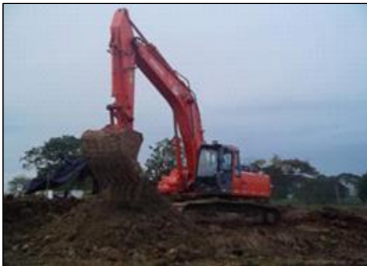
Fotografía 2-26: Excavaciones y rellenos para la conformación de una plataforma multipozo.
