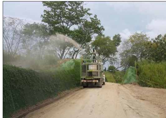
Fotografía 2-23: Revegetalización de taludes.
