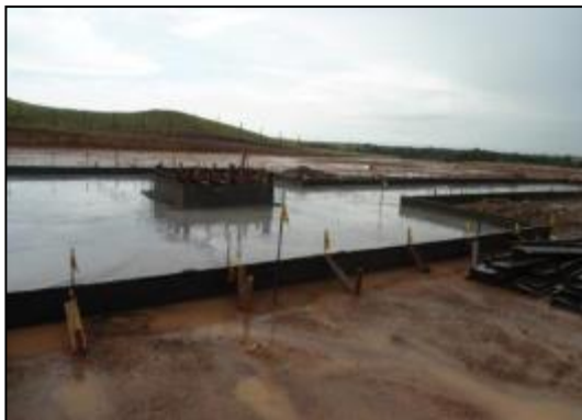
Fotografía 2-39: Alistado para la construcción de la placa de concreto del taladro.
