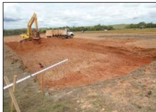
Fotografía 2-25: Limpieza y descapote para la construcción de una plataforma multipozo.
