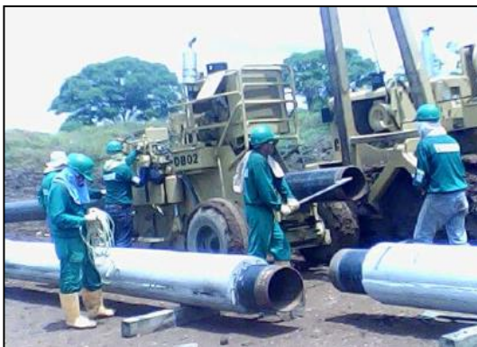
Fotografía 2-80: Doblado y soldadura de juntas.
