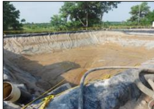
Fotografía 2-42: Instalación de la geomembrana para la construcción de piscinas.
