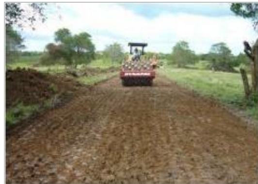
Fotografía 2-13: Descapote de un acceso vial.
