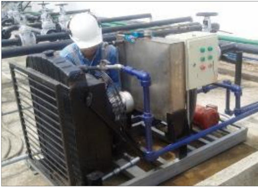
Fotografía 2-94: Intercambiador y Aero-enfriador.
