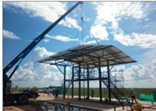
Fotografía 2-69: Proceso constructivo del cargadero de crudo.
