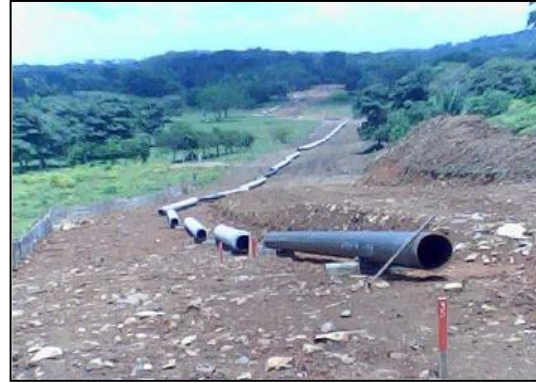
Fotografía 2-79: Tendido típico de una línea de flujo.
