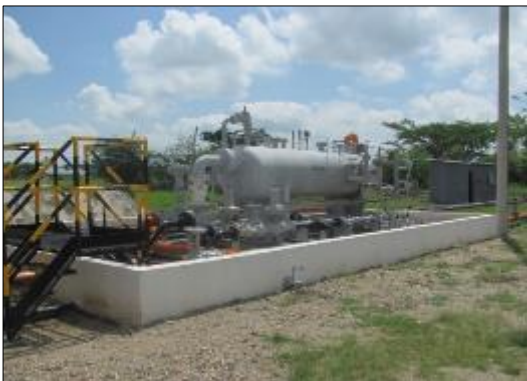
Fotografía 2-87: Separador trifásico horizontal.
