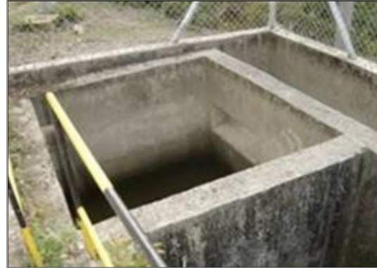
Fotografía 2-32: Obras típicas de construcción de un skimmer.
