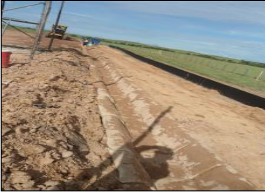
Fotografía 2-33: Cunetas de aguas lluvias terminada en sacos rellenos suelo-cemento.
