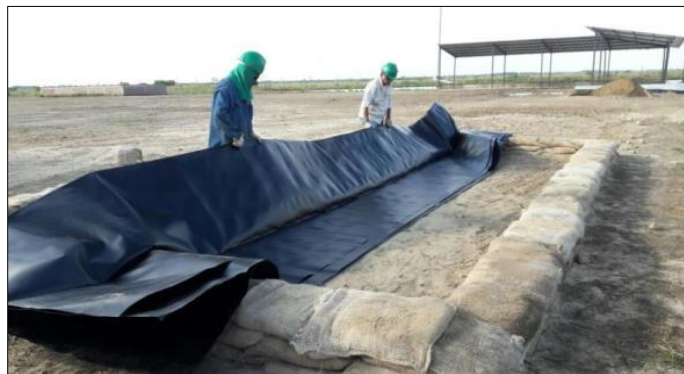
Fotografía 2-48: Diques para equipos auxiliares.
