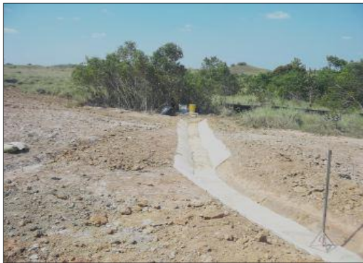
Fotografía 2-21: Descole en saco-suelo cemento.
