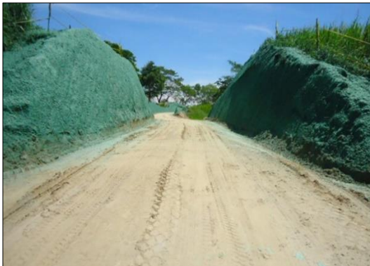
Fotografía 2-23: Revegetalización de taludes.
