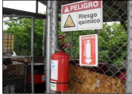
Fotografía 2-61: Caseta o área para almacenamiento de químicos tipo.
