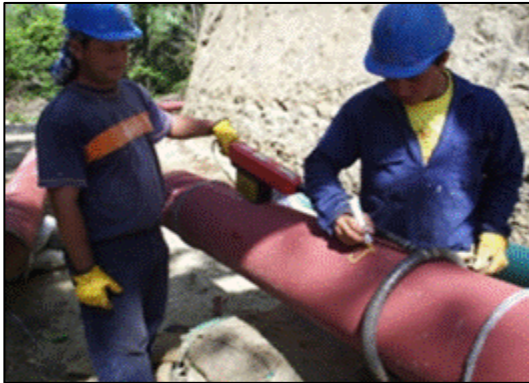
Fotografía 2-84: Vereda del revestimiento de la tubería. Detección de puntos de falla.
