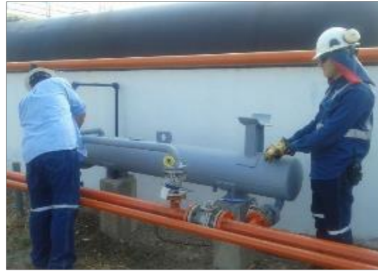
Fotografía 2-94: Intercambiador y Aero-enfriador.
