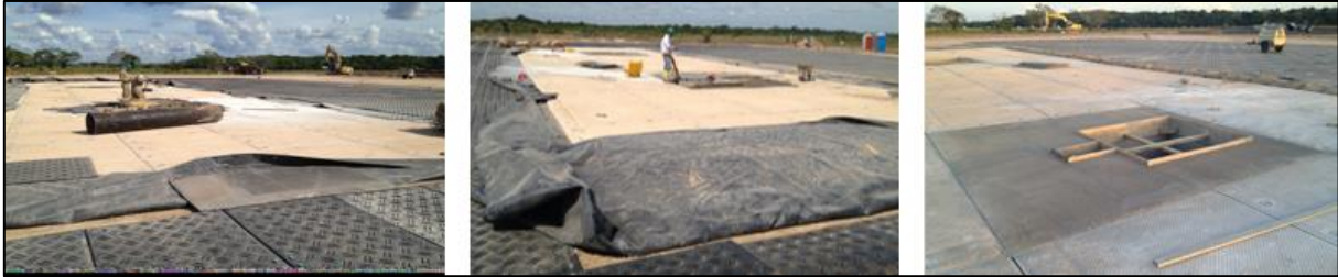
Fotografía 2-46: Superficie modular portátil - instalación.
