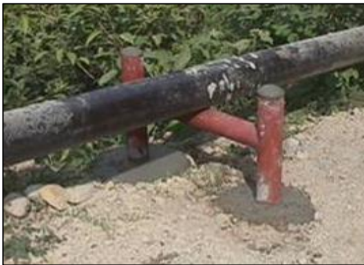
Fotografía 2-72: Equipo para sostener la tubería (Marcos "H").
