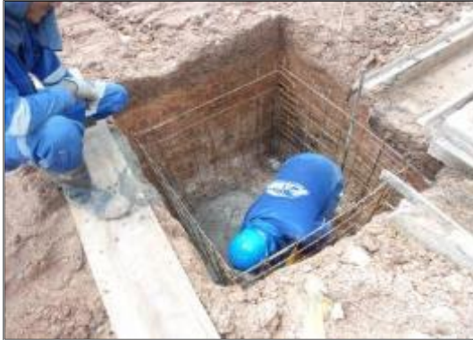
Fotografía 2-32: Obras típicas de construcción de un skimmer.
