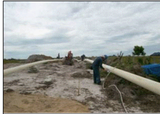
Fotografía 2-84: Vereda del revestimiento de la tubería. Detección de puntos de falla.
