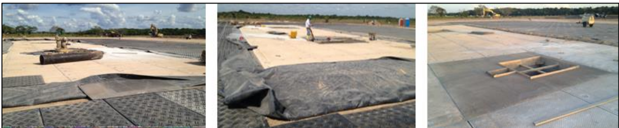
Fotografía 2-48: Superficie modular portátil - instalación.
