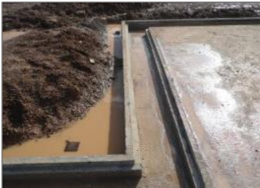
Fotografía 2-31: Cunetas en concreto fundidas en sitio para manejo de aguas aceitosas.
