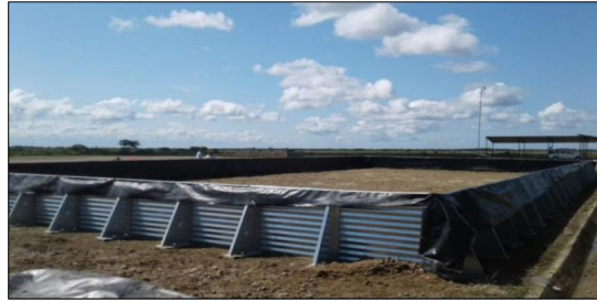
Fotografía 2-49: Diques para tanques de almacenamiento.
