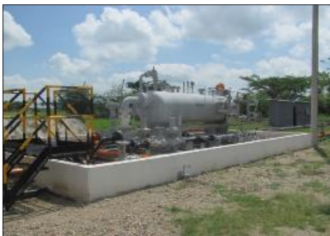
Fotografía 2-97: Separador trifásico horizontal.
