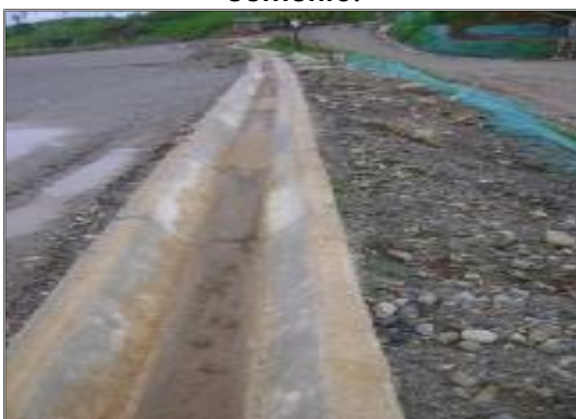
Fotografía 2-35: Cunetas de aguas lluvias terminada en sacos rellenos suelo-cemento.
