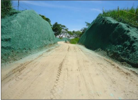
Fotografía 2-25: Revegetalización de taludes.
