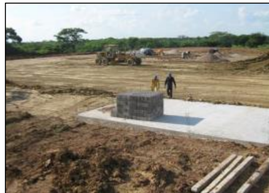
Fotografía 2-41: Alistado para la construcción de la placa de concreto del taladro.
