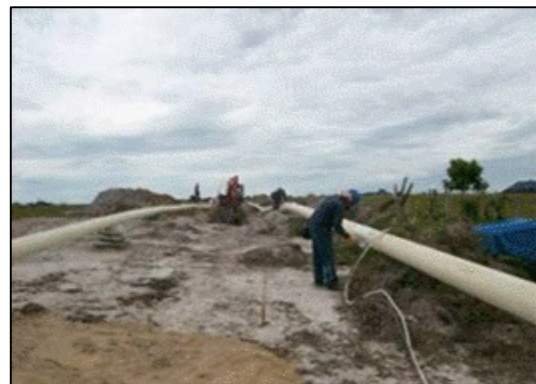
Fotografía 2-94: Verificación del revestimiento de la tubería. Detección de puntos de falla.
