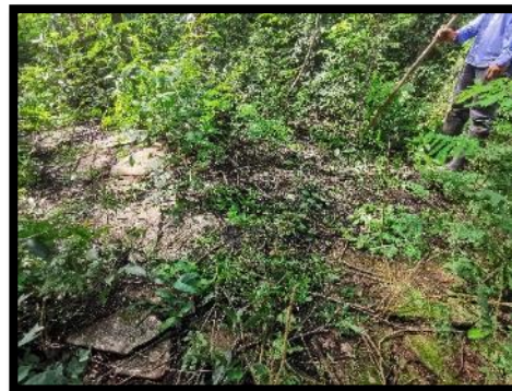
Fuente: Parex Resources Colombia LTD Sucursal, 2022. Fotografía 2-8: Infraestructura pozo Piñuela-1.
