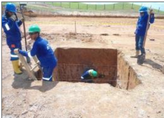
Fotografía 2-42: Obras típicas de construcción de contrapoza.
