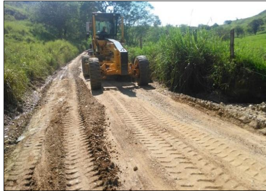
Fotografía 2-17: Nivelación de la subrasante y cuneteo.
