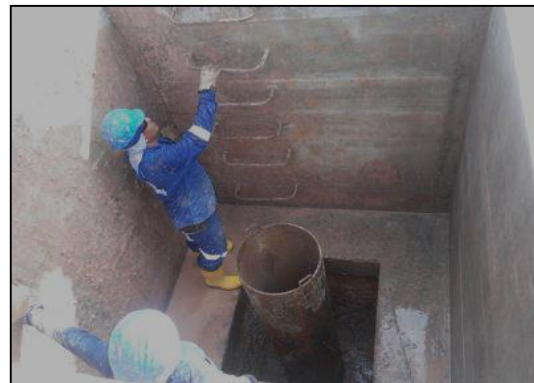
Fotografía 2-42: Obras típicas de construcción de contrapoza.
