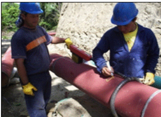
Fotografía 2-94: Verificación del revestimiento de la tubería. Detección de puntos de falla.
