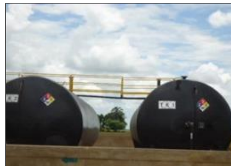
Fotografía 2-98: Tanque de almacenamiento en dique confinado.
