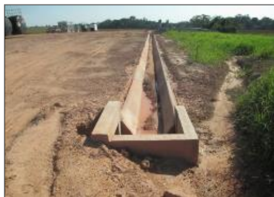
Fotografía 2-38: Construcción de cunetas perimetrales en concreto.
