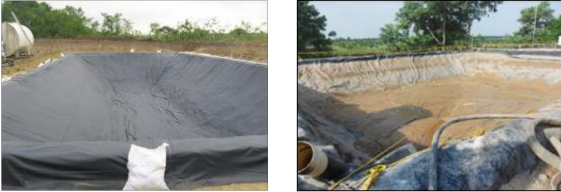
Fotografía 2-44: Instalación de la geomembrana para la construcción de piscinas.
