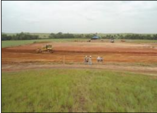
Fotografía 2-27: Limpieza y descapote para la construcción de una plataforma multipozo.
