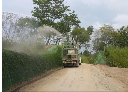
Fotografía 2-25: Revegetalización de taludes.
