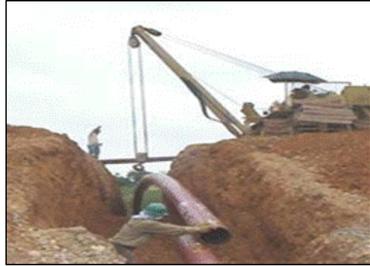
Fotografía 2-95: Verificación del revestimiento de la tubería. Detección de puntos de falla.
