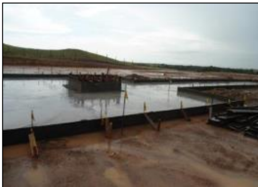
Fotografía 2-41: Alistado para la construcción de la placa de concreto del taladro.
