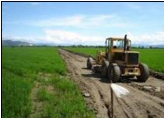
Fotografía 2-15: Descapote de un acceso vial.
