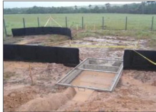
Fotografía 2-33: Obras típicas de construcción de un skimmer.
