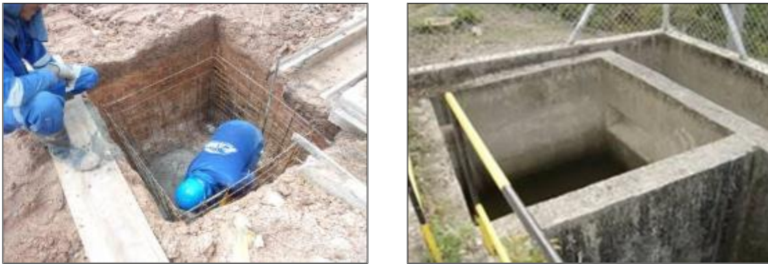
Fotografía 2-34: Obras típicas de construcción de un skimmer.
