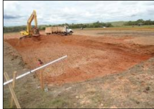
Fotografía 2-27: Limpieza y descapote para la construcción de una plataforma multipozo.
