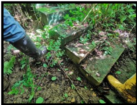
Fuente: Parex Resources Colombia LTD Sucursal, 2022. Fotografía 2-7: Infraestructura pozo Piñuela-1
