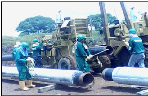
Fotografía 2-90: Doblado y soldadura de juntas.
