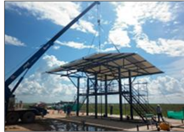
Fotografía 2-79: Proceso constructivo del cargadero de crudo.
