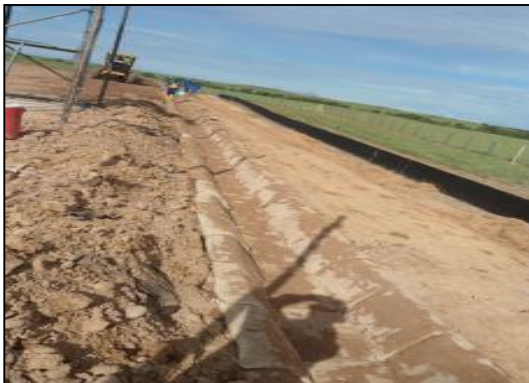
Fotografía 2-35: Cunetas de aguas lluvias terminada en sacos rellenos suelo-cemento.
