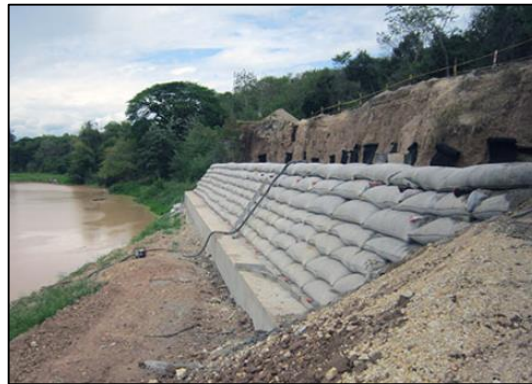
Fotografía 2-26: Muro de contención.
