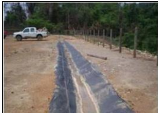
Fotografía 2-36: Cunetas en geomembrana para manejo de aguas lluvias.
