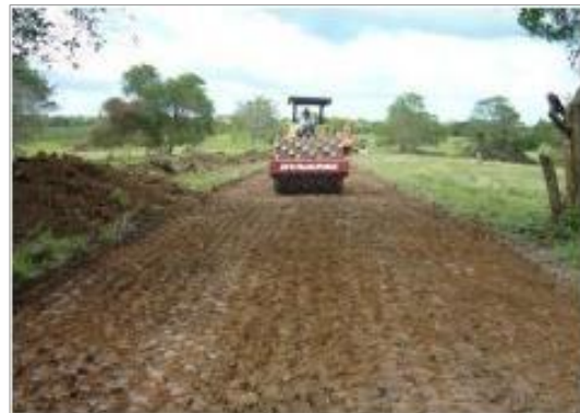
Fotografía 2-15: Descapote de un acceso vial.
