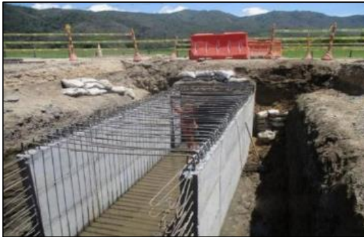
Fotografía 2-19: Proceso constructivo de un box culvert en una vía de acceso.
