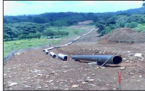
Fotografía 2-89: Tendido típico de una línea de flujo.
