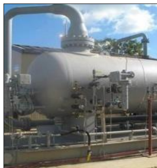
Fotografía 2-77: Separador trifásico.
