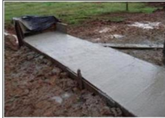
Fotografía 2-18: Proceso constructivo de una alcantarilla en una vía de acceso.
