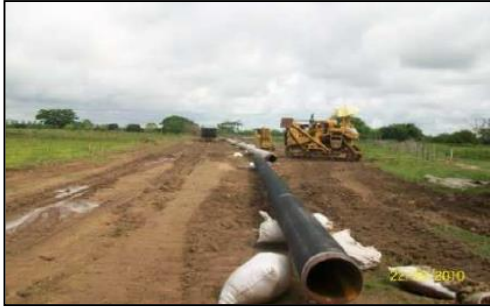
Fotografía 2-89: Tendido típico de una línea de flujo.
