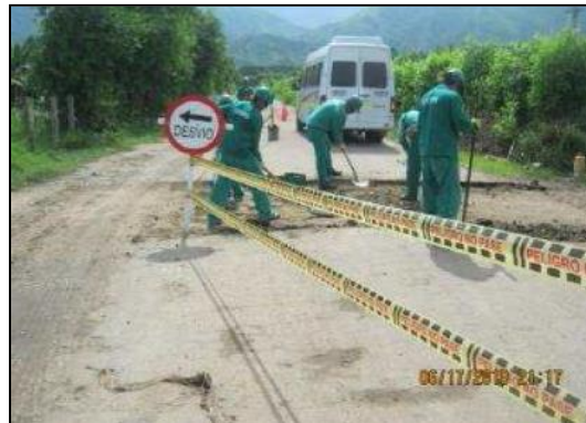
Fotografía 2-86: Cruce de vía tipo por la construcción de una línea de flujo.
