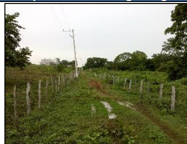
Estado vía. E: 4841071,00; N: 2710938,00.
