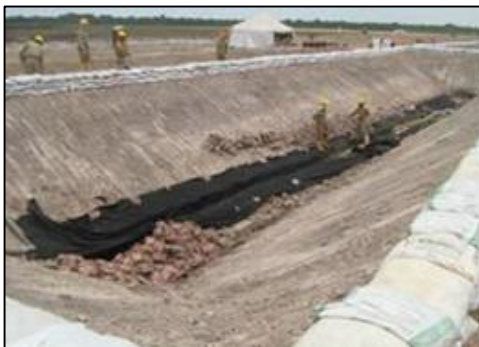
Fotografía 2-45: Instalación de barrera de sacos de suelo en el perímetro para el anclaje de la geomembrana y del dren francés.
