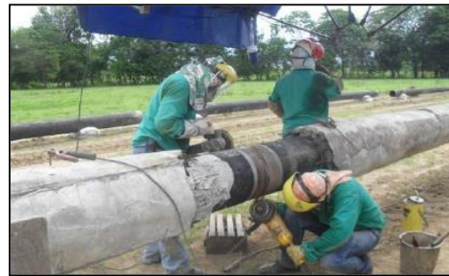
Fotografía 2-90: Doblado y soldadura de juntas.
