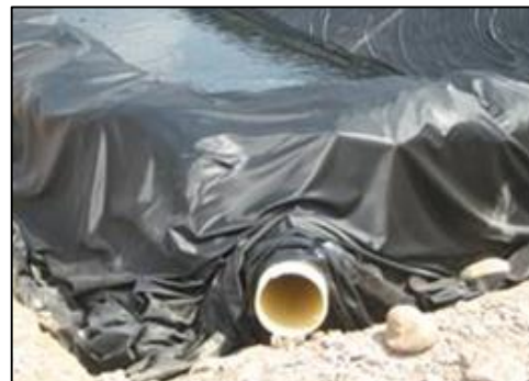
Fotografía 2-46: Tubo de 8" que sirve para evacuar el agua que por nivel freático llega a caja de bombeo.
