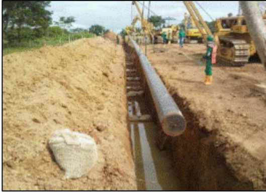
Fotografía 2-95: Verificación del revestimiento de la tubería. Detección de puntos de falla.
